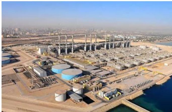
Figura 4: Dos Desaladoras Multietapas en Arabia Saudí. Estas plantas utilizan agua del mar Árábigo para la desalinización y la producción de agua potable.
