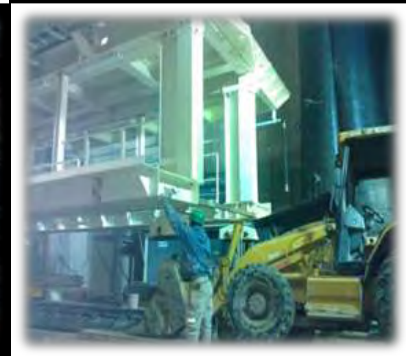
Maniobras para el descenso y desalojo de bote de rezaga de 20m 3 , aumentando los ciclos con ayuda de la Grúa Radial, al igual que el descenso de Gantry's faltantes
