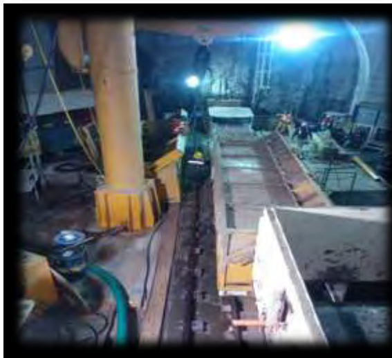
Maniobras para el descenso y desalojo de bote de rezaga de 20m 3 , aumentando los ciclos con ayuda de la Grúa Radial, al igual que el descenso de Gantry's faltantes
