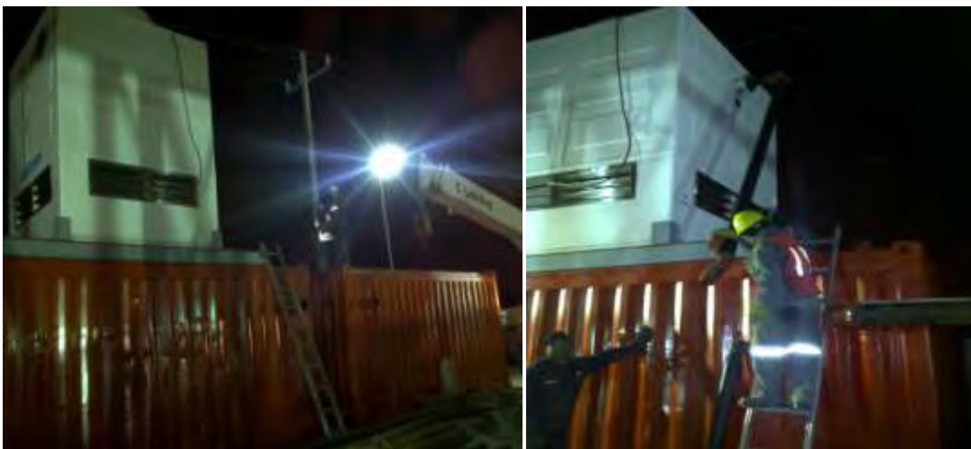
Torre de enfriamiento
