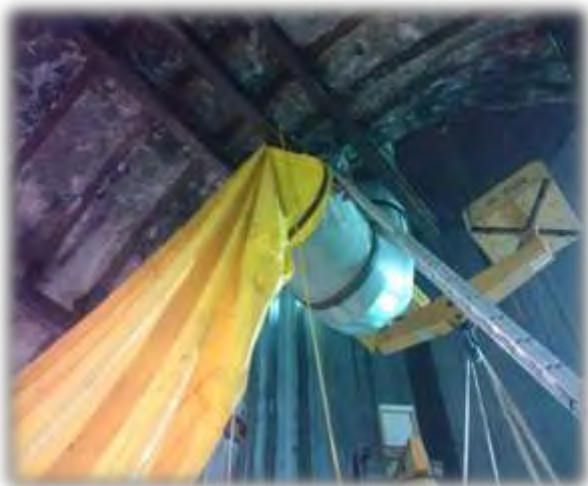
Maniobras para el descenso del Anillo de Dovelas en fondo de lumbrera al igual que su acomodo en carros doveleros con la ayuda de la Grúa Radial 10ton, colocación de Ducto de Manga de Ventilación y colocación de la primer Manga de 100mt.
