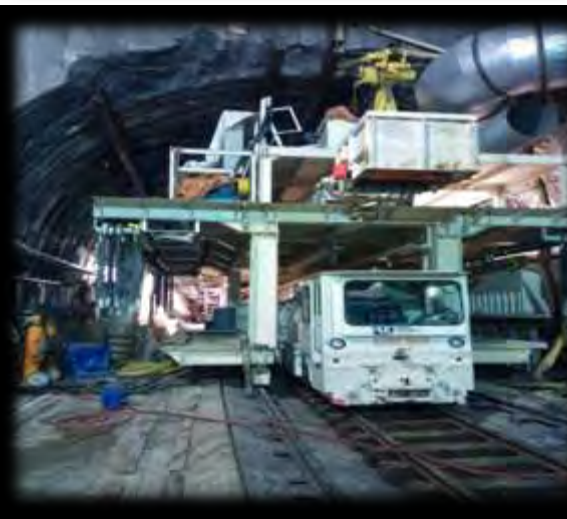
Maniobras para el descenso y desalojo de bote de rezaga de 20m 3 , aumentando los ciclos con ayuda de la Grúa Radial, al igual que el descenso de Gantry's faltantes
