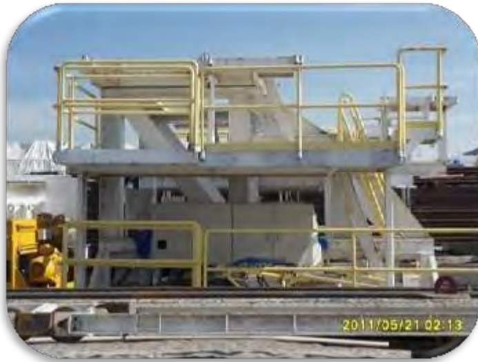
Vista del Andamio principal del Erector
