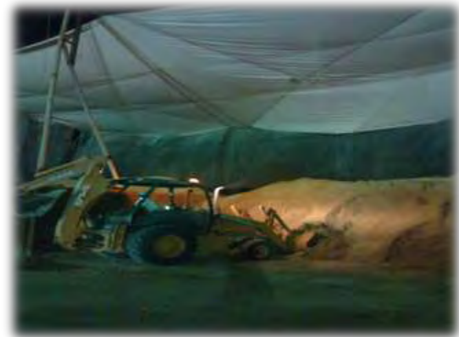
Construcción de dos Diques de Almacenamiento de Material (Grava y Arena) para la fabricación de mortero.
