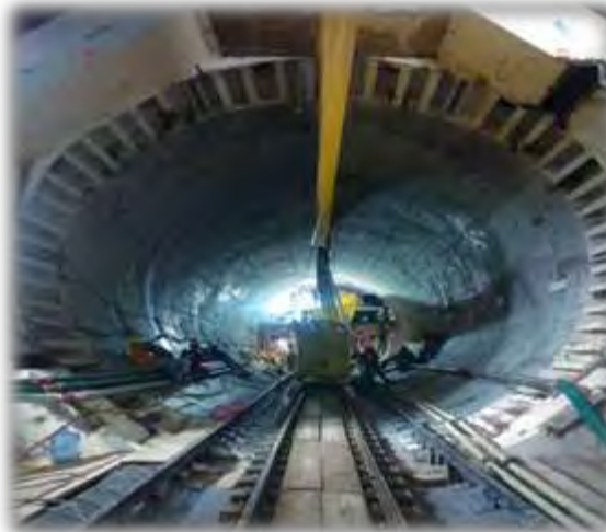
Maniobras para el descenso del Anillo de Dovelas en fondo de lumbrera al igual que su acomodo en carros doveleros con la ayuda de la Grúa Radial 10ton, colocación de Ducto de Manga de Ventilación y colocación de la primer Manga de 100mt.
