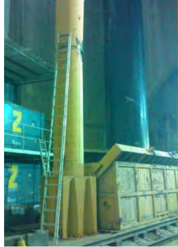
Desalojo de bote de rezaga a superficie Cambio de bote de rezaga a carro plano
