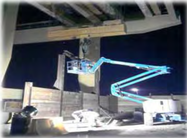
Realización de Dique de Rezaga Provisional
