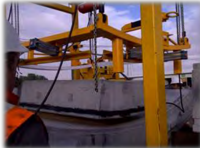
Logística para acomodo de dovelas en pila y revestimiento de las mismas.
