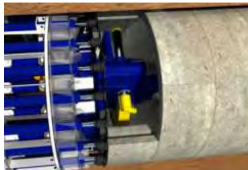
Montaje del anillo de concreto
