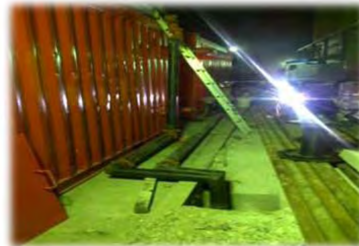
Colocación de Torre de Enfriamiento y líneas de llegada de Caliente y saliente de Agua Fría
