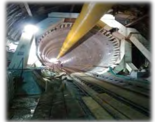
Maniobras para el descenso del Anillo de Dovelas en fondo de lumbrera al igual que su acomodo en carros doveleros con la ayuda de la Grúa Radial 10ton, colocación de Ducto de Manga de Ventilación y colocación de la primer Manga de 100mt.
