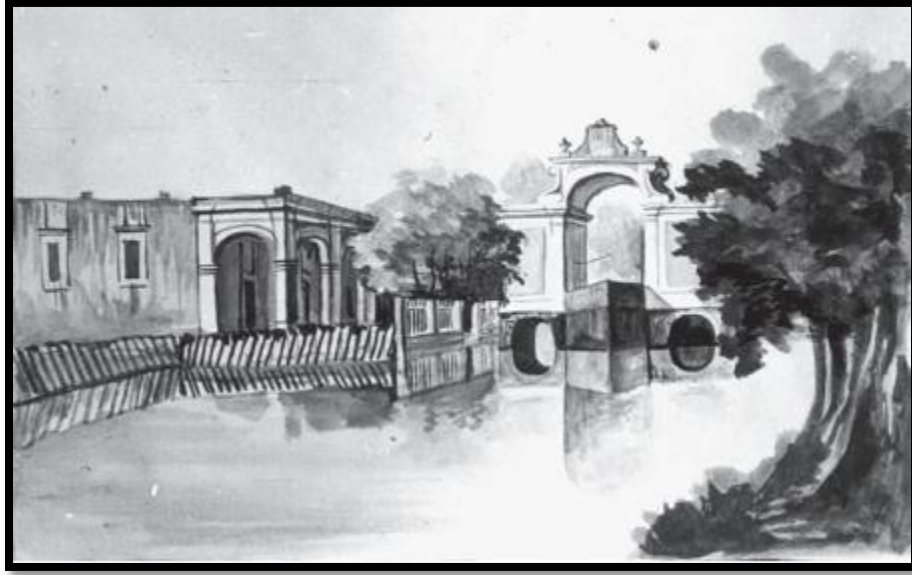
Figura (26). - La Garita y Puente de la Viga, en donde se aprecian los dos “ojos” por donde pasaban las canoas (Peralta-Flores, 2010)
