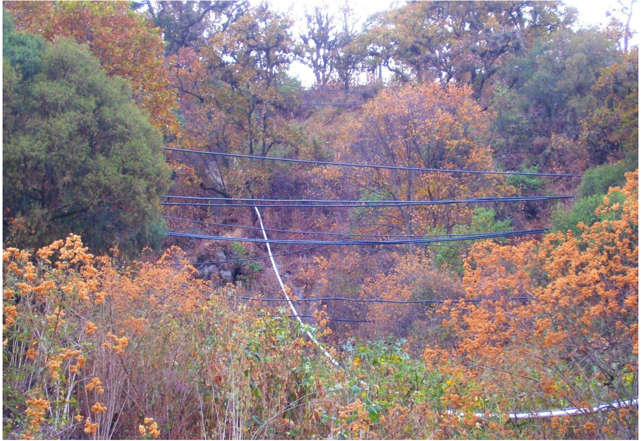
Imagen 10. Mangueras cruzan barrancas y cerros, son las fuentes de abastecimiento de las comunidades de Hueyapan y Tetela del volcán
