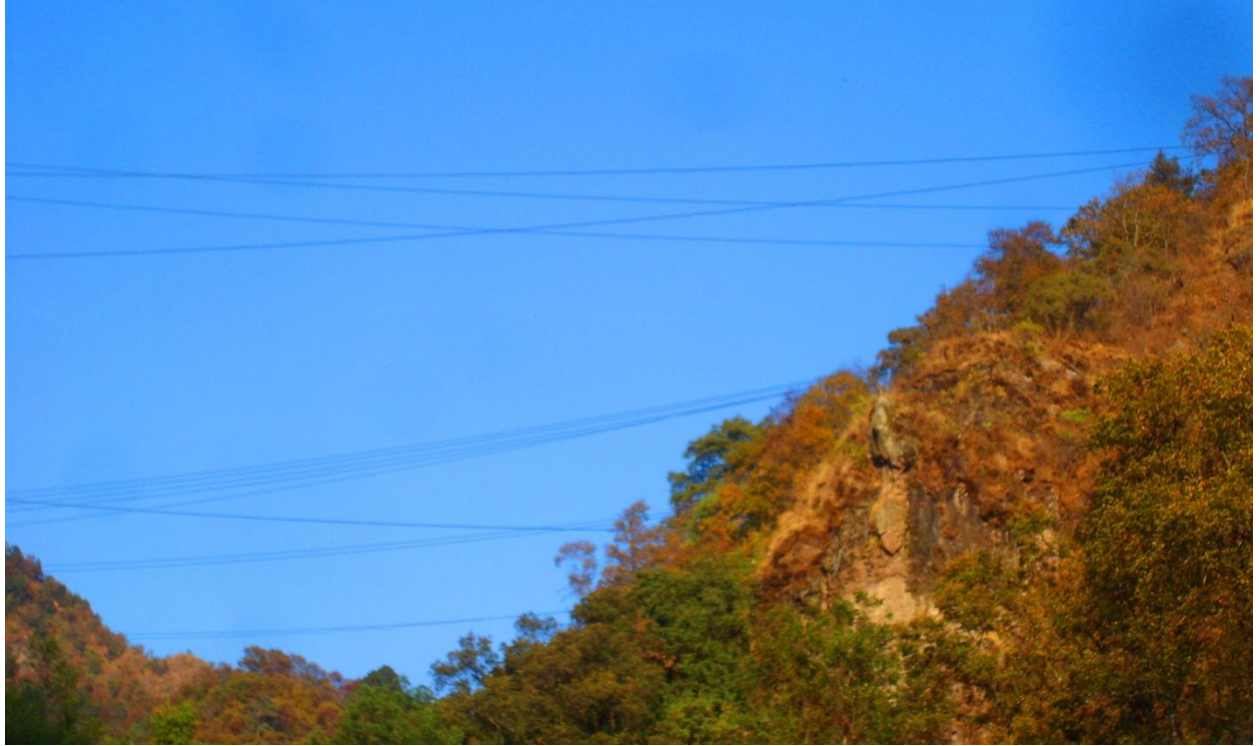
Imagen 9. Mangueras de agua (tuberías), que cruzan barrancas y cerros, para el abastecimiento de agua de las comunidades de Tetela del volván y Hueyapan.
