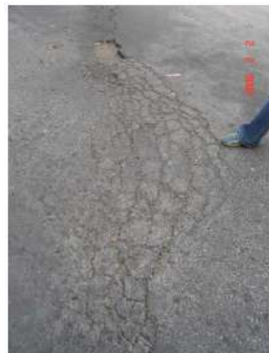
Fig. 1.28 Grieta con arreglo Echelón Fig. 1.29 Grieta con arreglo Anastosomado
