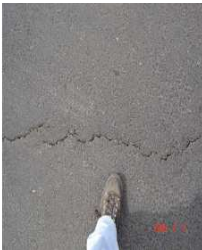
Fig. 1.28 Grieta con arreglo Echelón Fig. 1.29 Grieta con arreglo Anastosomado
