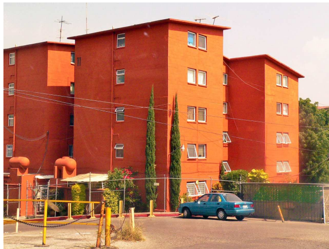
Fig. 3.10 Edificios del conjunto José María Morelos
