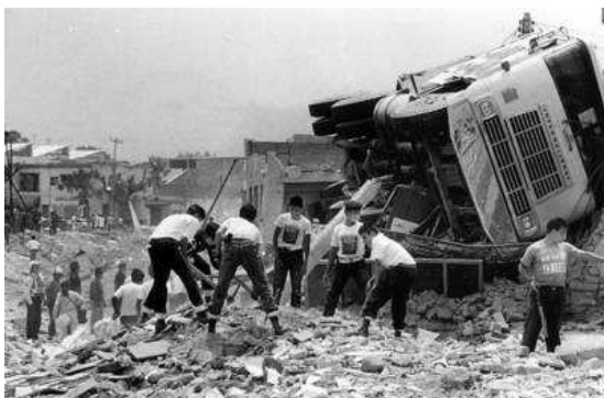
Fig. 1.7 Explosión de drenaje en de Guadalajara. 22 abril 1992
