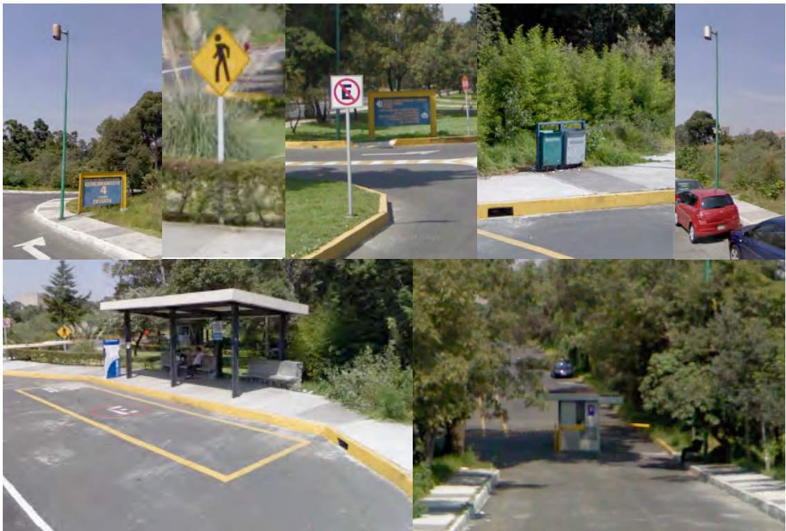
Alumbrado ,Señalización, Botes de Basura, Paradas de Puma Bus, y Caseta de vigilancia.
