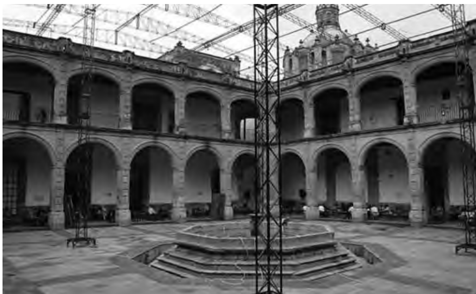
Antigua Cubierta del Ex Hospital de San Hipólito, sus apoyos descansan en el patio central
