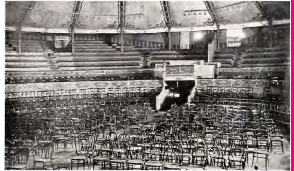
Vista interior del Circo Teatro Orrin, que no pudo durante muchos años en la plaza de Villamil, y que, por haberse terminado el contrato con el Ayuntamiento, que autorizaba su existencia en ese sitio público, ha empezado a ser demolido.
