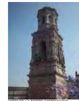
VISTA DE LA TORRE CAMPANARIO
