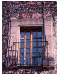
VISTA DE LA VENTANA CON VISTA HACIA LA CALLE DE HEROES
