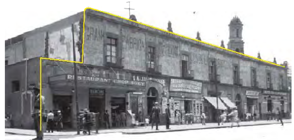
Hospital de Dementes de San Hipólito, en su demolición parcial
