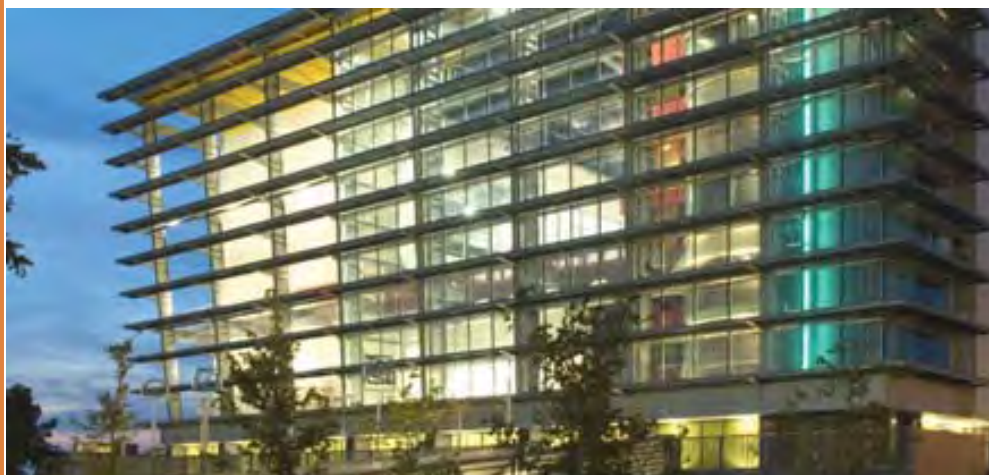
Proyecto construido de Escuela Nacional de Circo en Montreal
