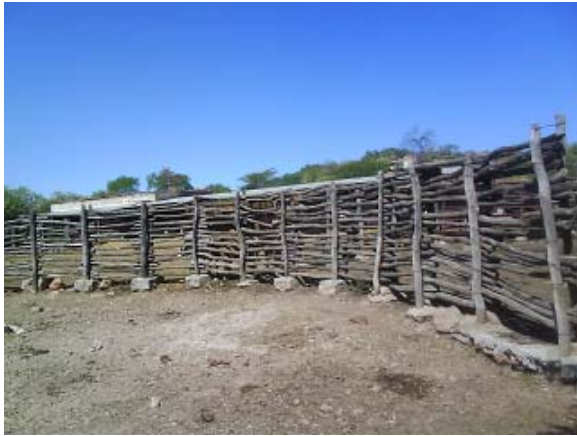
Divisiones de los corrales (31 de octubre 2010)
