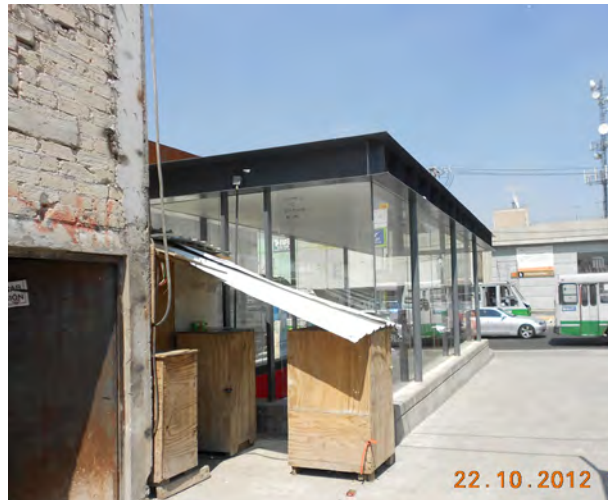
Estación del metro Mexicalzingo
