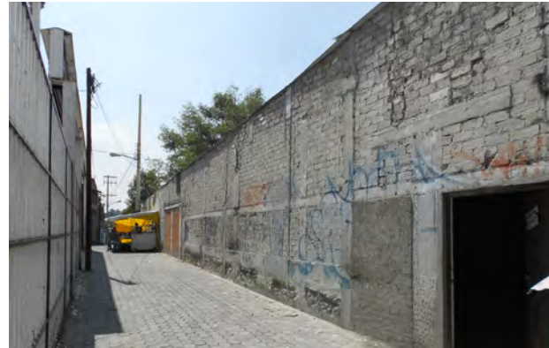
Entrada al callejón, colindando con bodega de obras del metro.
