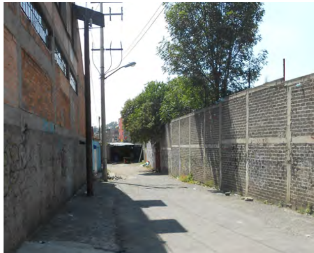
Barda del terreno.
