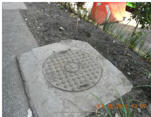
Registro de luz y obras de mejoramiento urbano.
