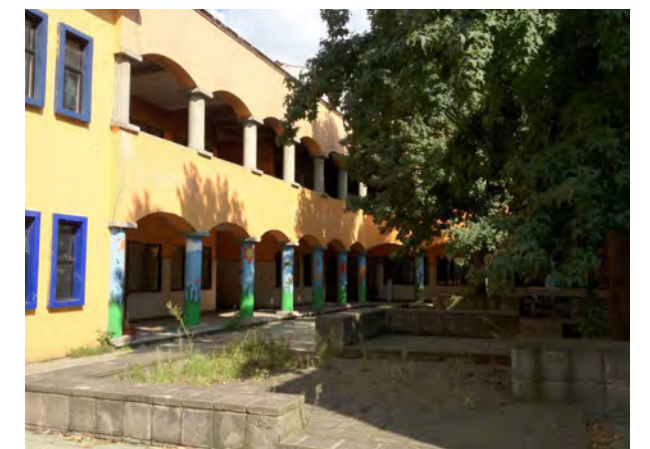
Patio Fachada norte
