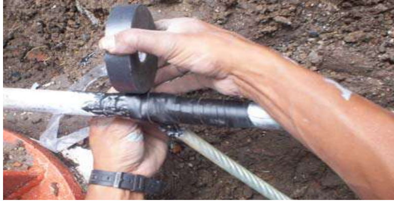
Figura 4.22 Aislamiento del cable y el tubo galvanizado.
