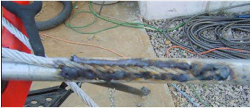
Figura 4.19 Soldadura entre cable y tubo galvanizado.
