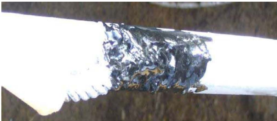
Figura 4.21 Aplicación del Sellado de resina en la parte galvanizada.
