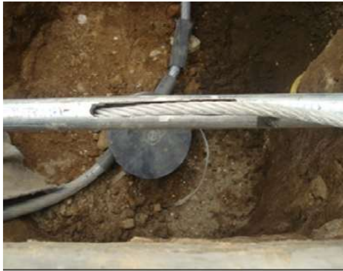
Figura 3.18 Colocación del cable dentro del tubo de acero galvanizado
