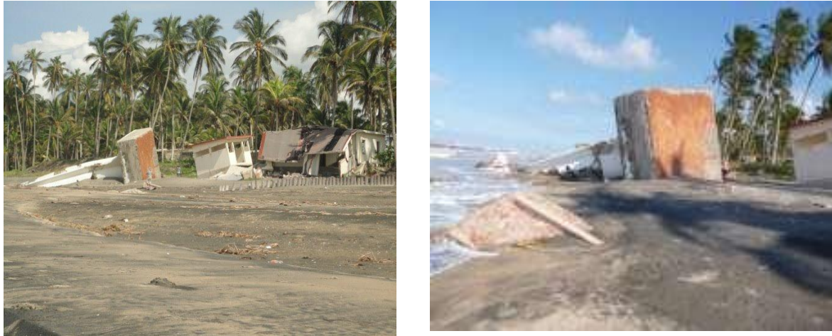
Figura 11. Faro derrumbado a consecuencia de la erosión costera en Barra de Tupilco.
