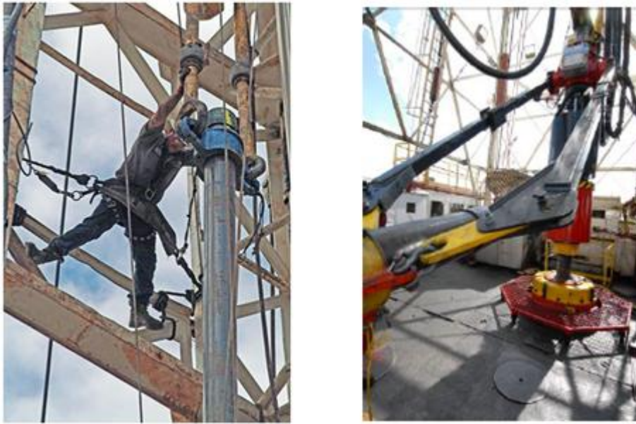
Figura 4.15. Condiciones típicas de trabajo de un chango (izquierda), Top Drive recogiendo la TR desde la rampa en V (derecha). (SPE- 105304).
