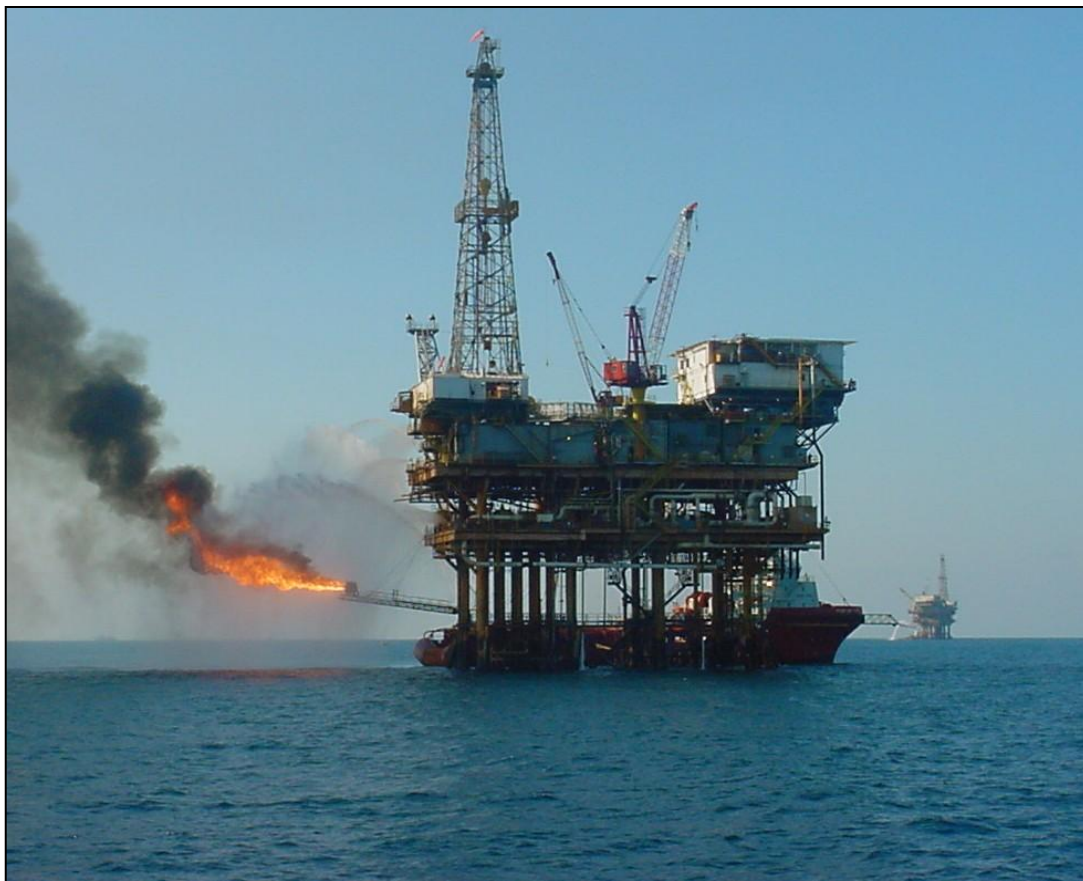
Figura 1.12. Plataforma fija con equipo de perforación y producción con barco abastecedor. (PEMEX-PEP).
