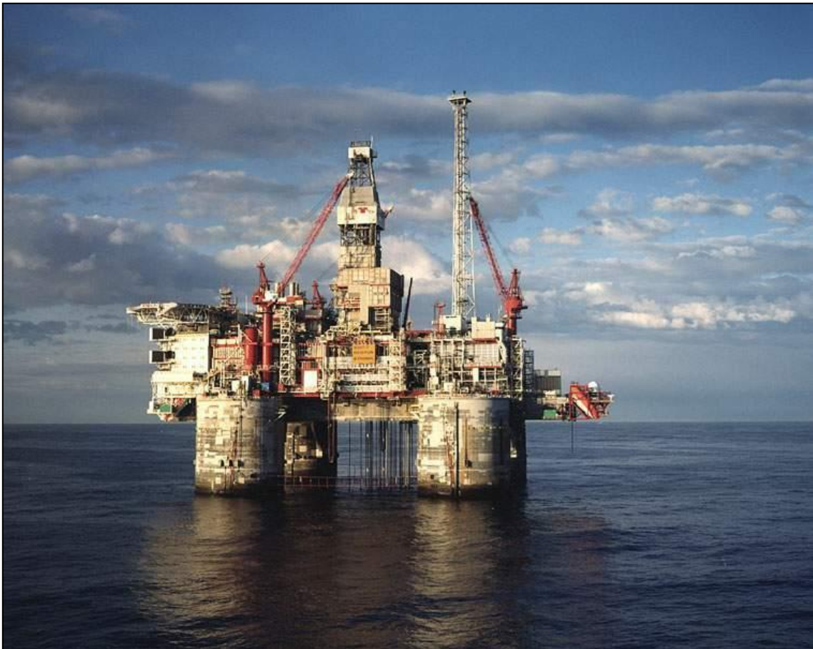
Figura 1.11. Plataforma de patas tensionadas (TLP). (PEMEX)
