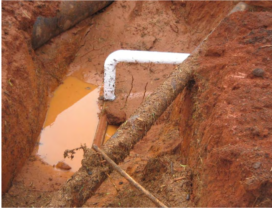
Fig. 219.-Area de interconexiones, se ve la interconexión y el congelamiento de la línea hasta este punto y el taponamiento por dentro en el ducto.
