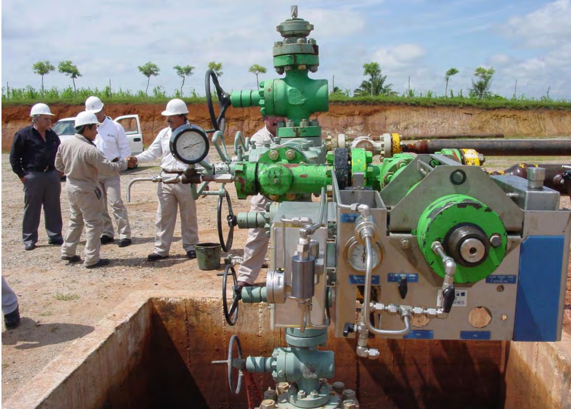
Fig. 233.- Prueba Tecnológica de Válvulas laterales de uso severo en el pozo Mundo Nuevo 201.
