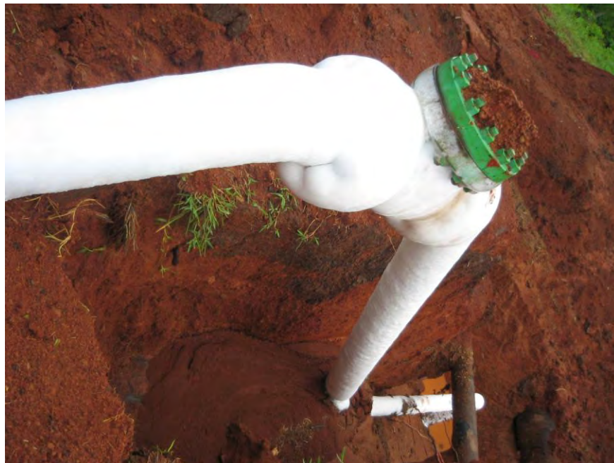
Fig. 217.-Area de interconexiones y congelamiento de la línea. Fuente.- Coordinación de Construcción y Mantenimiento. A.I.M.
