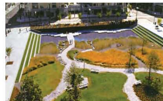
ANÁLOGO: El Parque Urbano Tanner Spring situado a orillas del río Willamette en Oregón (EUA), es parte de un gran proyecto de recuperación de una antigua zona industrial y su actual vocación residencial. El proyecto fue concebido para que el paseante se vaya encontrando con distintos habitats —que recuperan la vegetación nativa— y riachuelos a medida que se acerca al estanque situado por debajo del nivel de calle.
