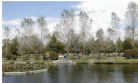
Lago de agua reciclada en la Universidad Ibero Americana de Puebla. Descontaminación productiva y recuperación del medio ambiente natural. En operación desde hace 17 años. El primer mantenimiento mayor para extracción de lodos se hizo después de 15 años de operación.
