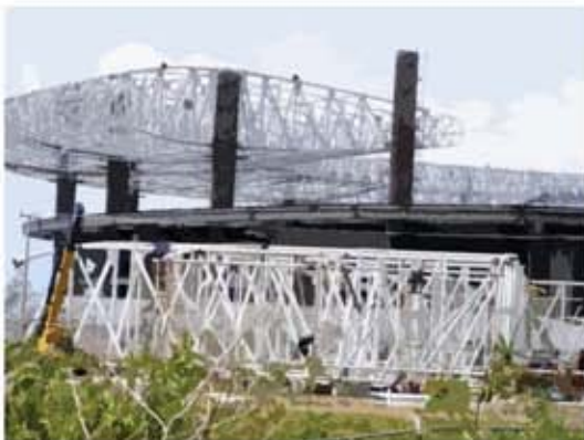
Vista de las armaduras durante la construcción (Foto: Club Guadalajara).
