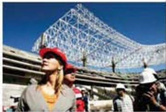
Vista Interior durante la Construcción (Foto: Periódico reforma).
