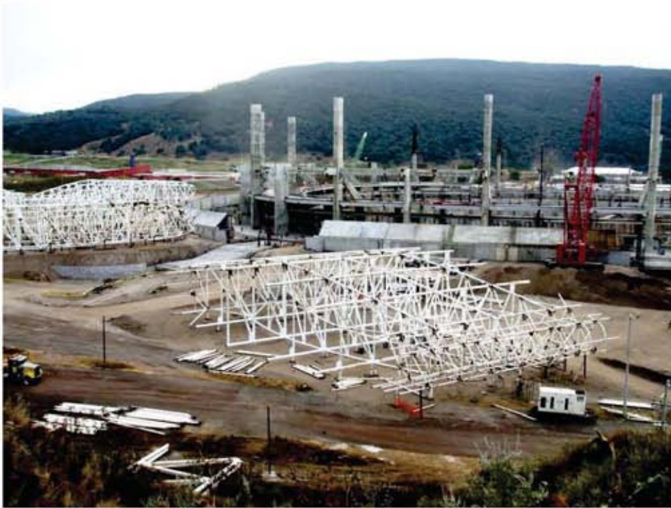
Armado de la estructura previo a montaje (Foto: Club Guadalajara).
