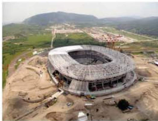
Vista Aérea de la estructura de cubierta, al finalizar el proceso de montaje (Foto: Club Guadalajara).
