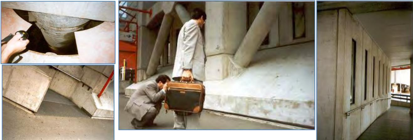
**Ilustración VII-11.- Elementos de separación de la Estructura Aislada**
