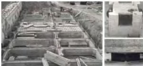
**Ilustración V-22.- Proceso constructivo durante la colocación de aisladores, en Ancona**
