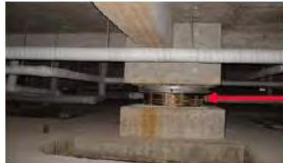
**Ilustración VI-9.- Edificios con aisladores en Cantón, China**
