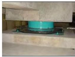
**Ilustración VI-15.- Edificio de RC en Japón con aislamiento de base**
