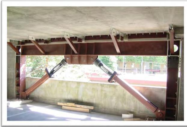
**Ilustración II-12.- Ubicación típica de Amortiguadores**
