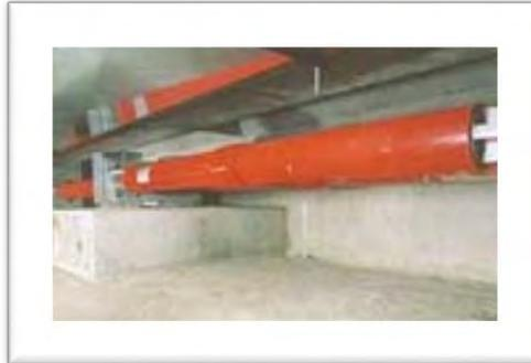
**Ilustración II-10.- Amortiguador de Robinson Seismic Ltd.**
