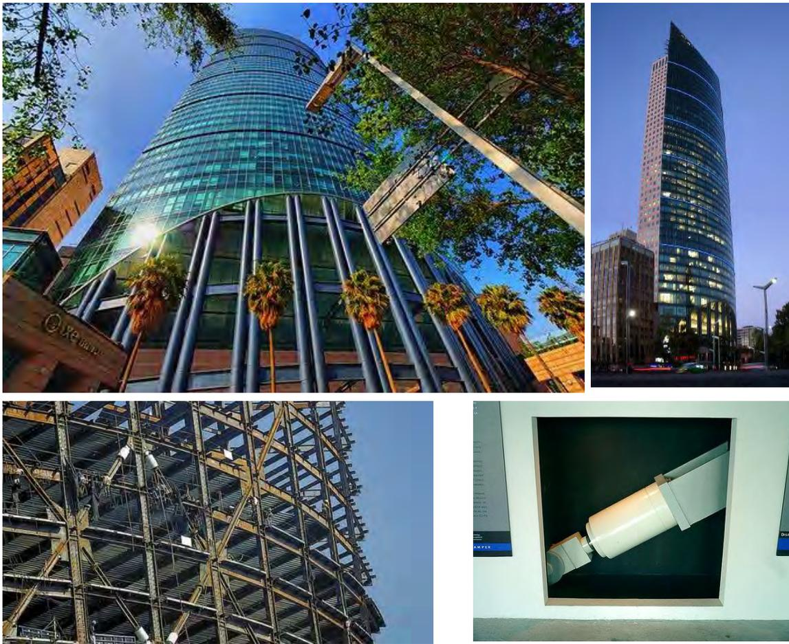
**Ilustración IV-9.- Torre Mayor, México DF, Detalle de Colocación de Amortiguadores y vista final del Amortiguador desde una de las Oficinas**
