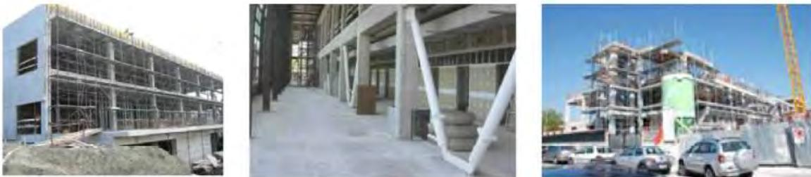
**Ilustración V-35.- Reforzamiento de Universidades con Amortiguadores en Contravientos**
