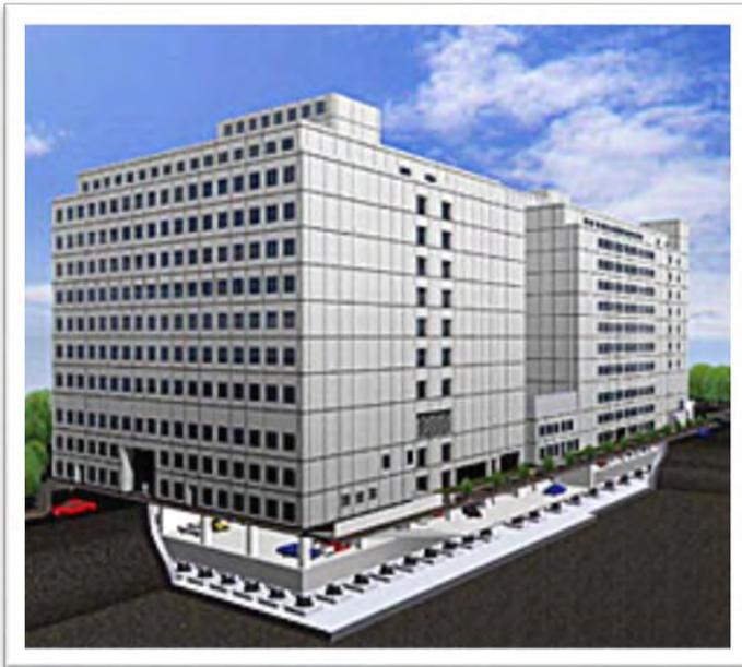
**Ilustración II-26.- Edificio con Aisladores de base**
