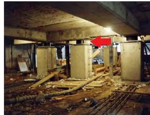
**Ilustración IX-10.- Corte de la cimentación de la Casa del Parlamento NZ**
