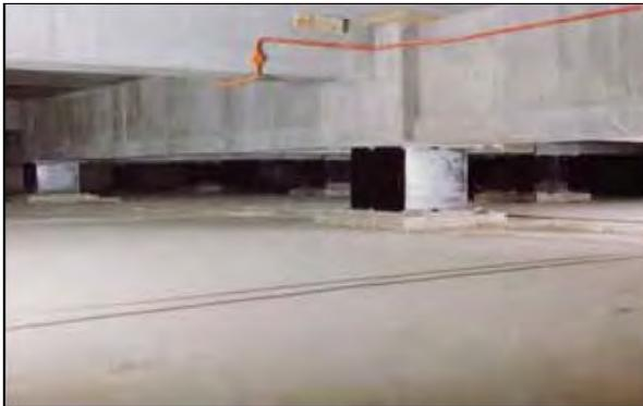
**Ilustración VII-22.- Aisladores de base de la Maquinaria de Prensa (Press Hall), en Petone, NZ**
