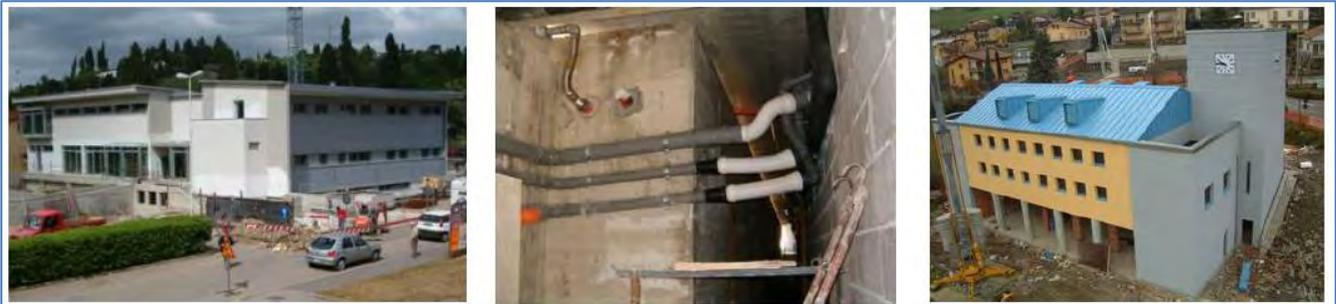
**Ilustración V-31. Edificios de emergencia con Detalles de conexión de Instalaciones en la cimentación de los aisladores de base**
