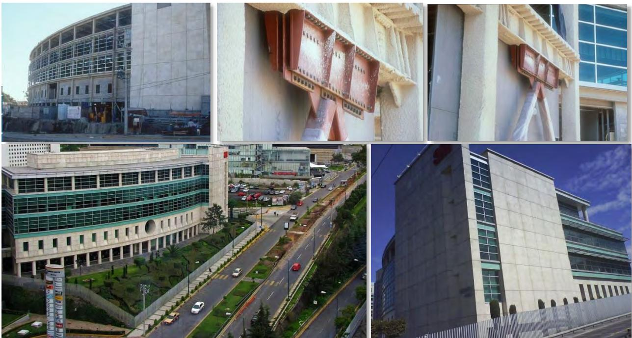
**Ilustración IV-10.- Disipadores tipo Amortiguador viscoelástico en el Corporativo 3M, en Santa Fé, México, DF**
