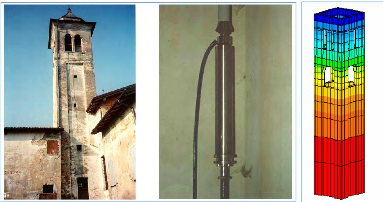
**Ilustración V-11.- Torre del Campanario de la iglesia San Giorgio en Trignano, dispositivo SMAD y Modelo de Elemento Finito para el análisis**
