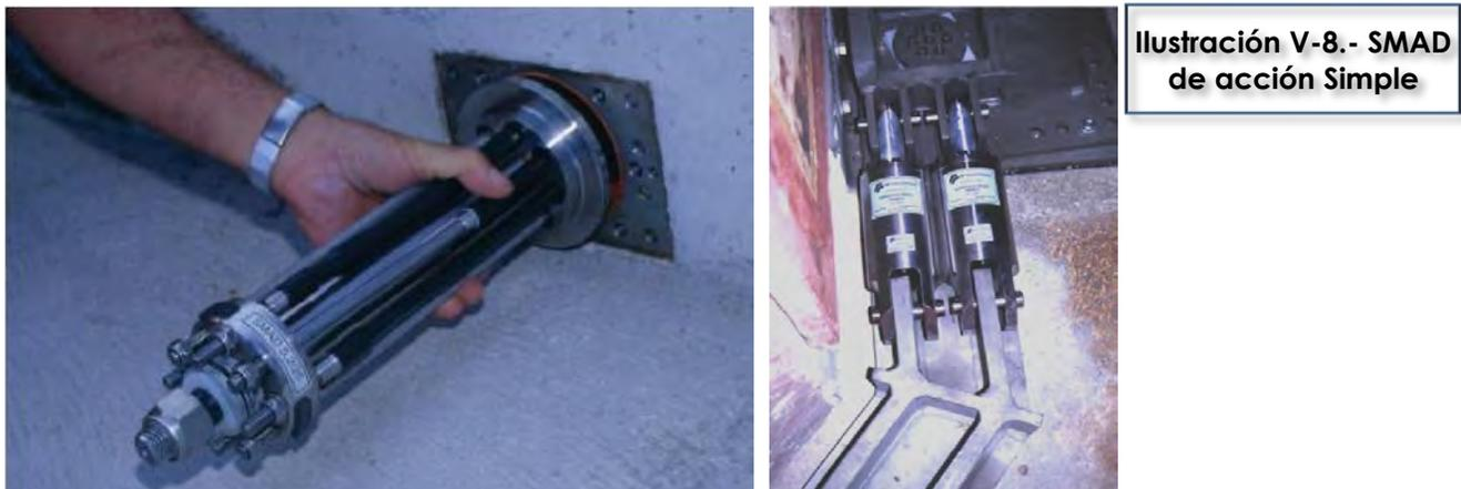
En particular, hemos ideado un sistema para la fijación de las dos fachadas del frente que son la parte más vulnerable de la estructura. En estos casos, de hecho, la aceleración sísmica tiende a generar el desgarro de la mampostería con el ataque de las cadenas en las paredes a sujetar. Por tanto, es apropiado que la conexión entre la pared y la cadena está constituida por un dispositivo capaz de limitar los esfuerzos transmitidos.
