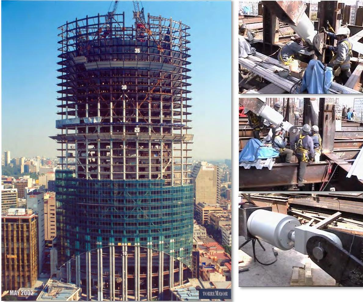
**Ilustración IV-8.- Amortiguadores durante la construcción, Torre Mayor, México DF**
