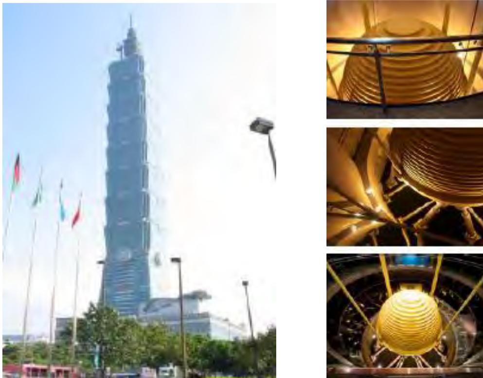
**Ilustración VI-32.- Torre Taipei 101, imagenes del Mass Damper en su estructura**
