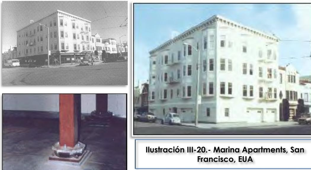
La estructura original es de marcos de acero para gravedad y muros de tabique de mampostería y granito sin refuerzo. Los aisladores FPS fueron instalados bajo las columnas de acero existentes con concreto nuevo en cada columna y un nuevo sistema de diafragma encima del nivel de aislamiento.
