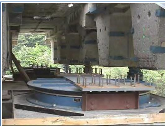
**Ilustración V-45.- Sustitución de aisladores dañados en los apoyos del viaducto Bolu, en Ankara, Turquía**
