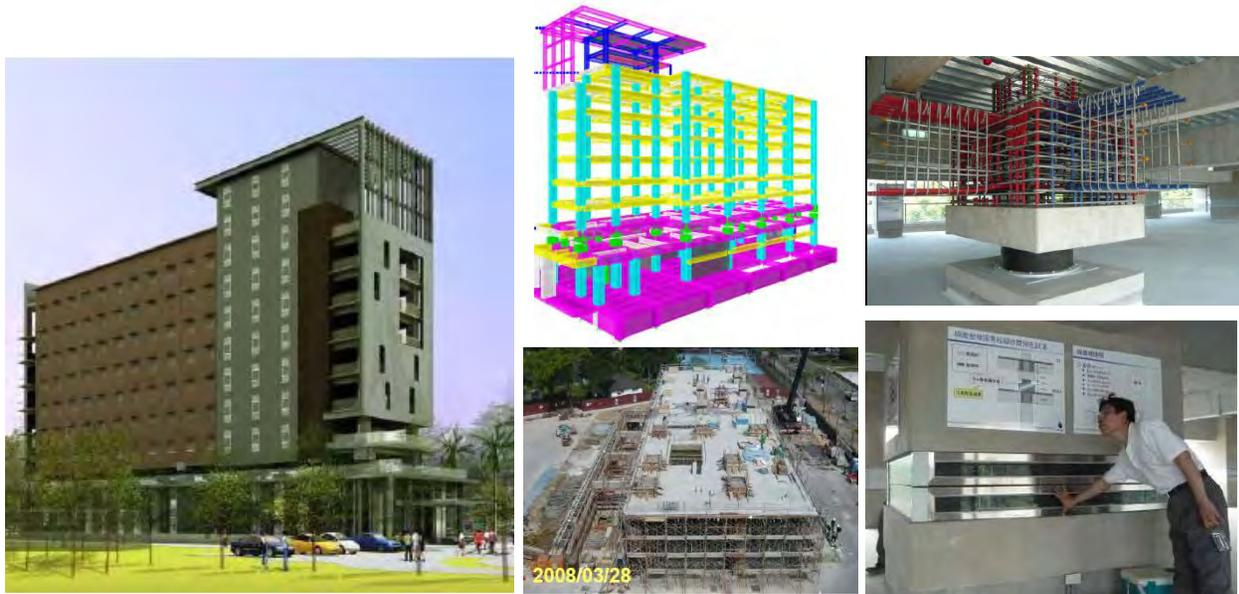
Constituyen el sistema de aislamiento, 19 aisladores de base tipo LRB's y 6 Amortiguadores viscoelásticos tipo VD's, (Ilustración VI.31).
