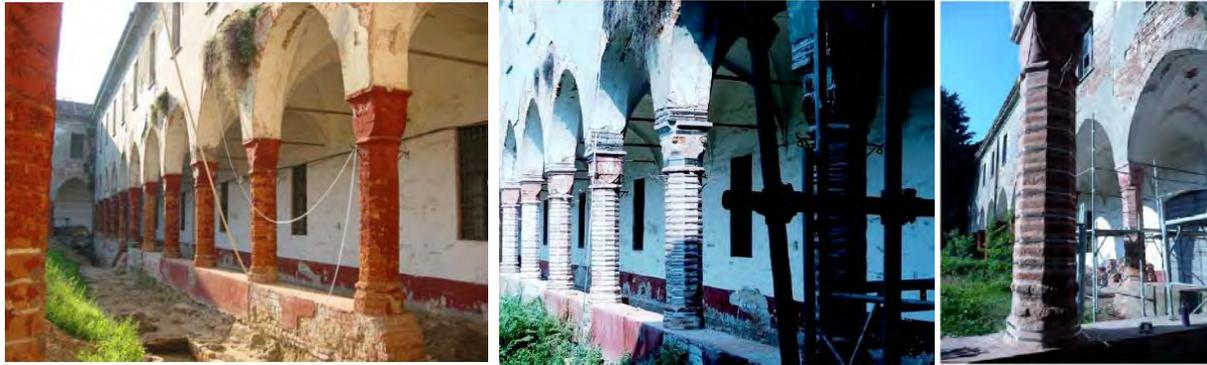
**Ilustración V-3.- Vista del reforzamiento de columnas con CAM**
