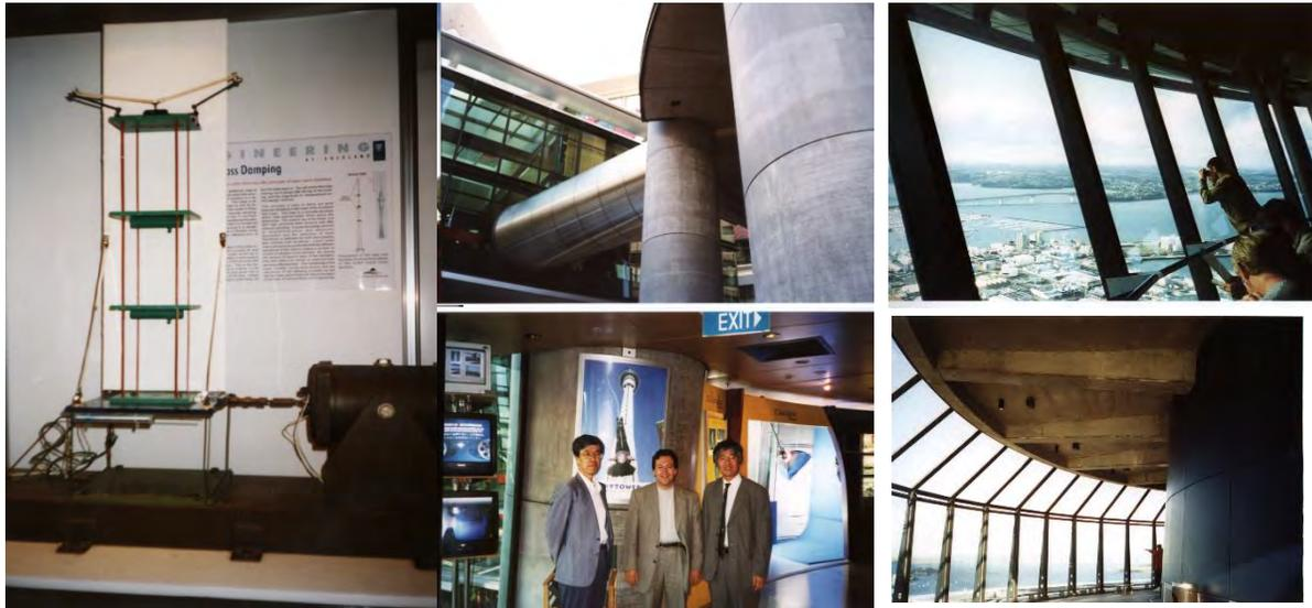
**Ilustración VII-24.- Mirador Sky Tower en Auckland, New Zealand, y maqueta que muestra la vibración amortiguada por la Masa deslizante (Mass Damper) en el Deck de visitantes**
