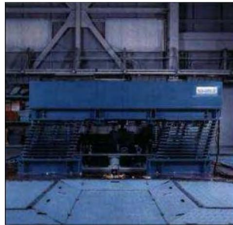
Este sistema de amortiguador de masa híbrido Shimizu, maximiza la eficiencia de la energía combinando el dispositivo TMD pasivo y el equipo de transmisión controlado por computador.
