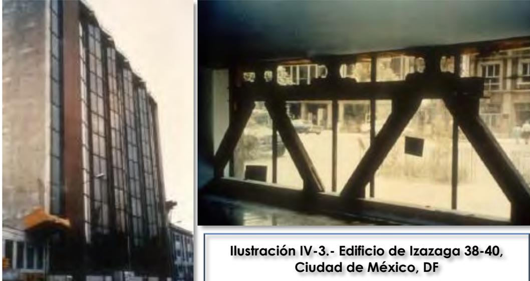
Con la incorporación de los disipadores ADAS se espera una reducción del 40% de la deformaciones de entrepiso máximos que se tenían en la estructura ya reforzada.
