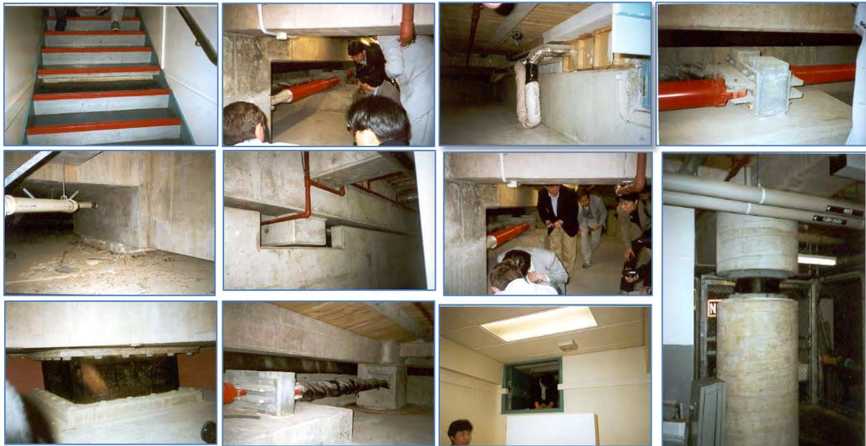
**Ilustración VII-10.- Detalles del Aislamiento de Base de la Central de Policía de Wellington**
