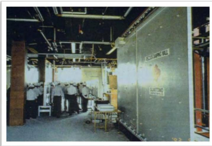
**Ilustración II-20.- Amortiguador tipo muro viscoelástico**
