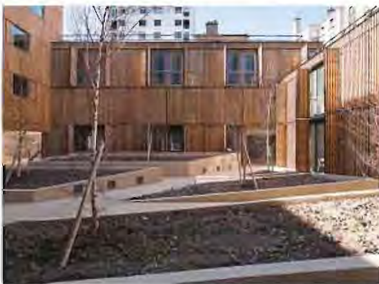
patio de residencia para estudiantes en París, Francia. 2007 LAN/Architecture. Imágenes de afasiaarq.blogspot.com
