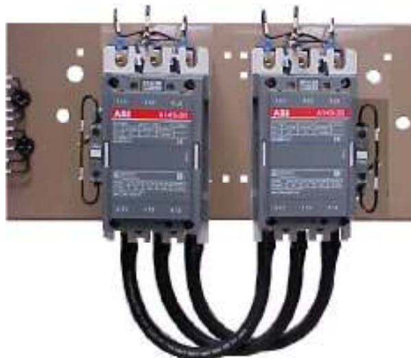
Figura 4.8 Transferencia por medio de contactores
