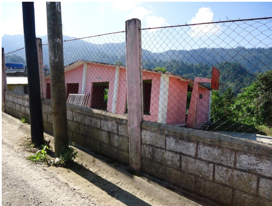
Fotografía 21. Escuela afectada por los procesos de remoción de masa.
