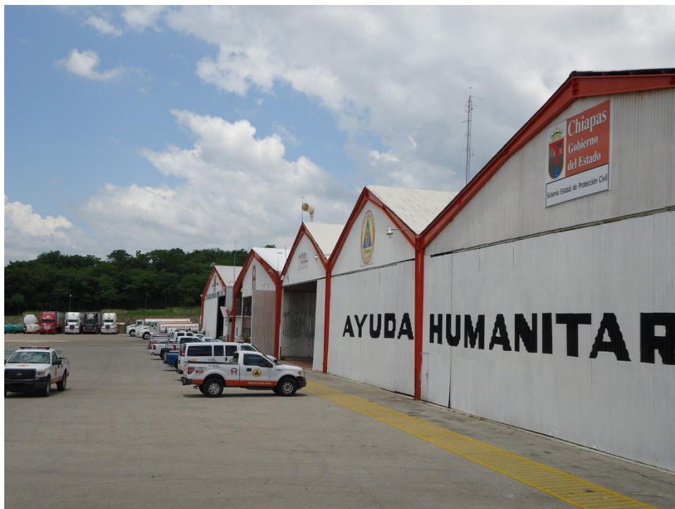
Fotografía 2. Instalaciones de Protección Civil, Tuxtla Gutiérrez, Chiapas.
