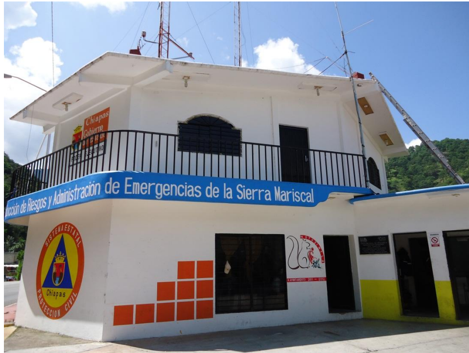
Fotografía 3. Protección Civil. Motozintla de Mendoza.
