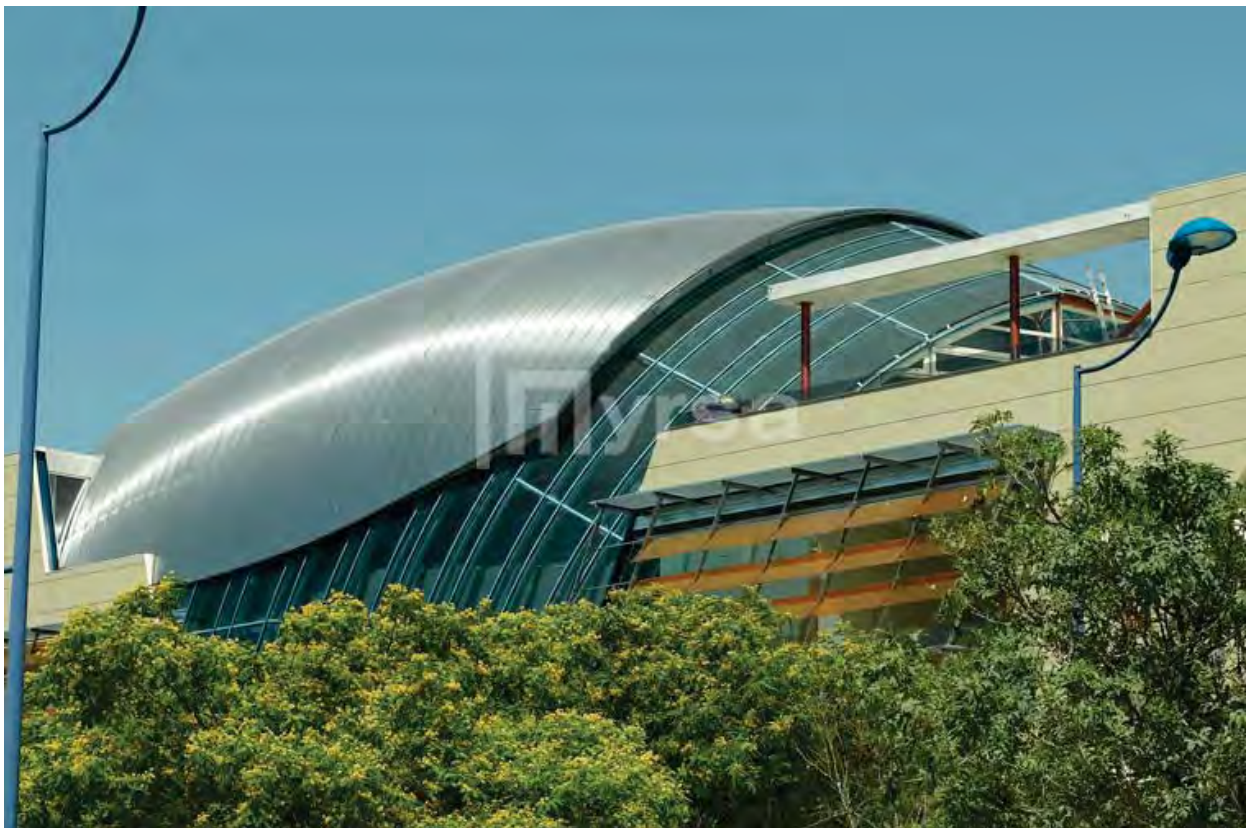
Imagen que muestra la aplicación de Cubierta ligera a base de paneles de aluminio marca british robertson.
