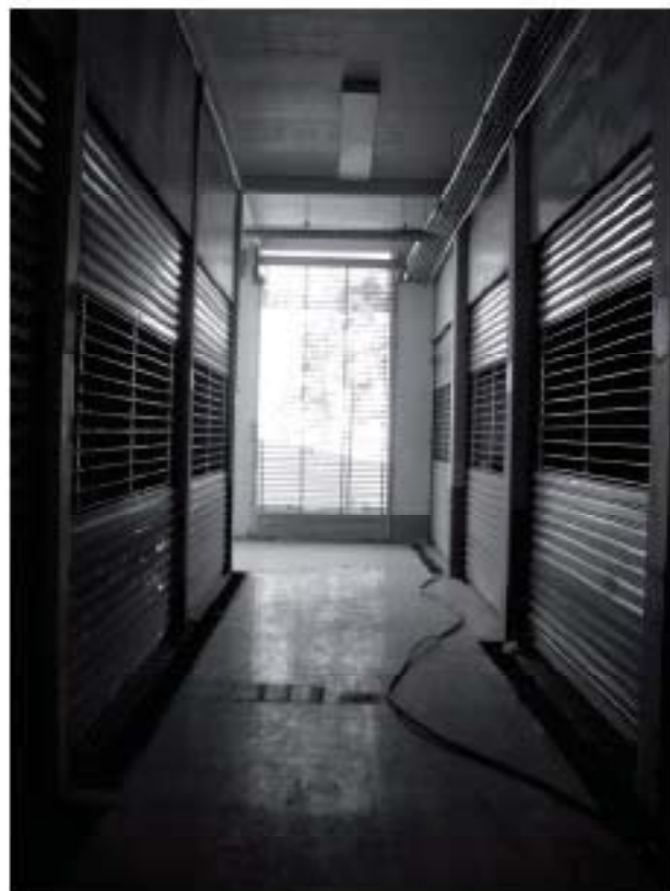
Vista desde planta baja hacia fachada oriente
