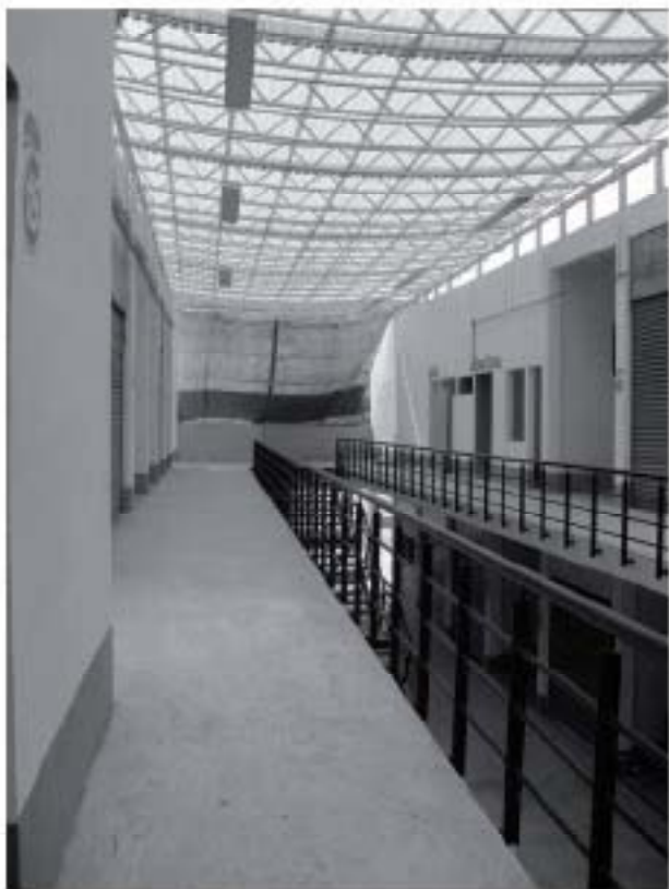
Vista desde planta alta hacia fachada oriente
