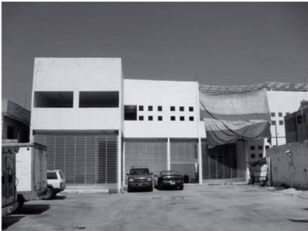
Fachada Principal del Mercado Cuauhtepc calle 20 de noviembre
