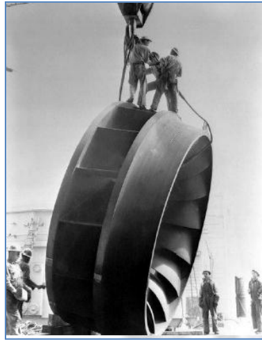
Figura 8.18 Fotografía de Turbina Francis Fuente: Internet
