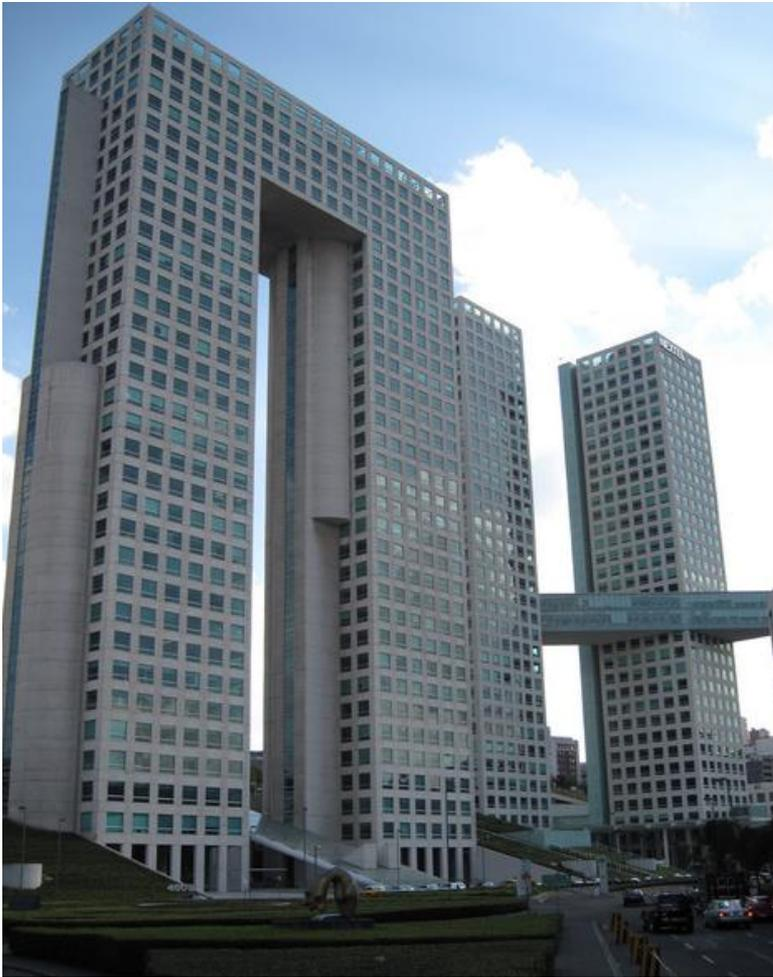
La mayor parte de este conjunto utiliza concreto con grano de mármol aparente y cincelado para las fachadas exteriores.
