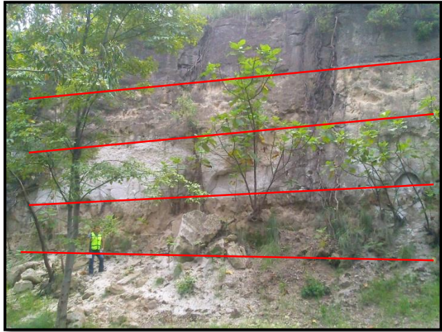
Fotografía 7: se muestran cinco unidades expuestas del talud escuela en el sitio de mayor altura.
