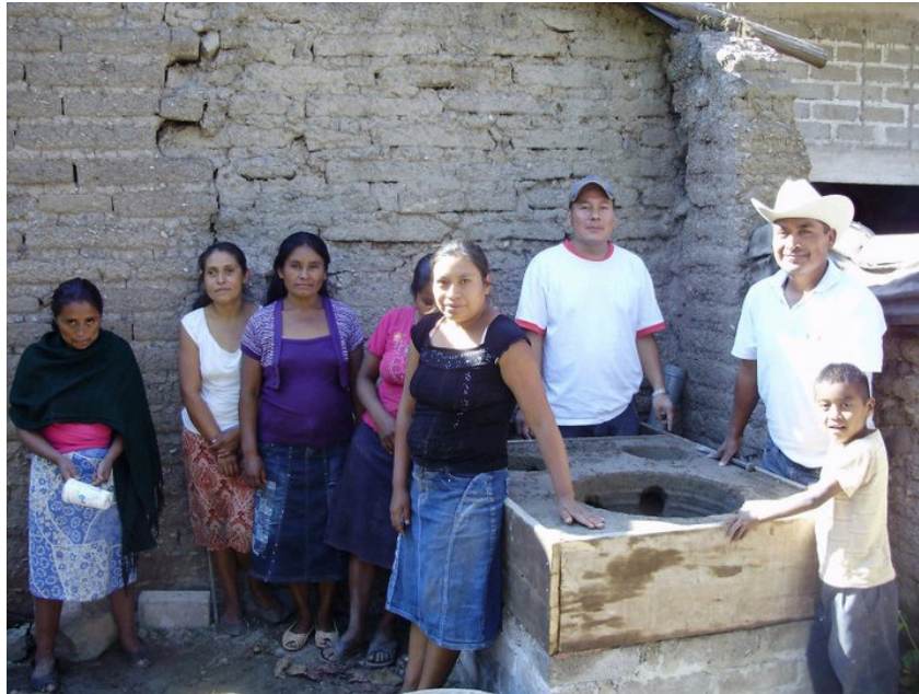
Figura 33. Mujeres durante la construcción de estufas en Patlacha, Copanatoyac. Diciembre de 2010.
