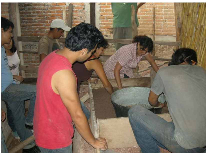
Figura 38. Construyendo estufas en Xalpatláhuac. Julio de 2011.
