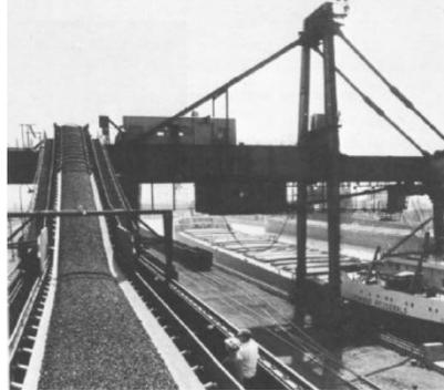
Imagen 2.2 Conveyer de alta capacidad de transporte de carbón
