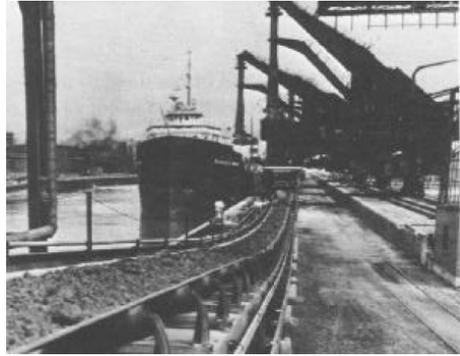
Imagen 2.15 Transportador de cinta con 60 pulgadas de ancho.
