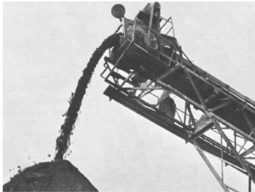
**Imagen 2.22 Vertido de agregado clasificado desde la polea de una cinta inclinada.**
