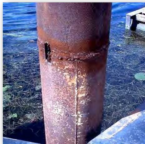
**Figura 7:** Efectos de la corrosión en las tuberías marinas, ocasionadas por la salinidad del mar.
