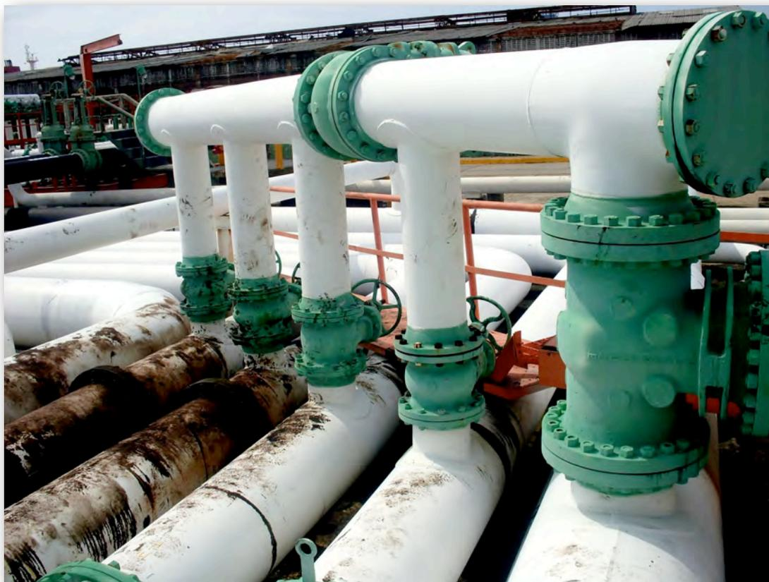
*Figura 5: Cabezal de tuberías, ejemplo de tuberías de sección circular.*
