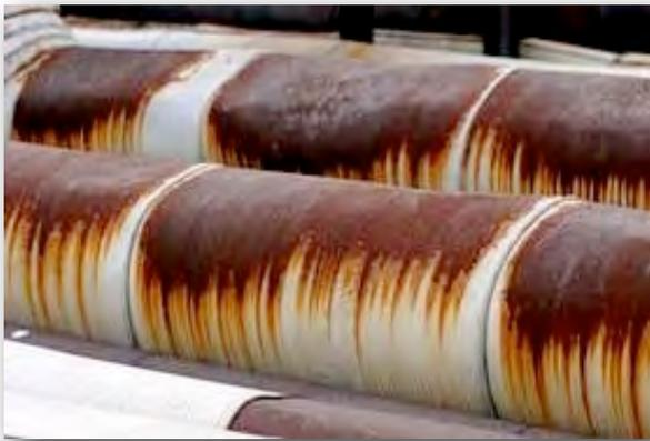
**Figura 6:** Efectos de la corrosión en las tuberías de proceso de una Terminal Marítima.
