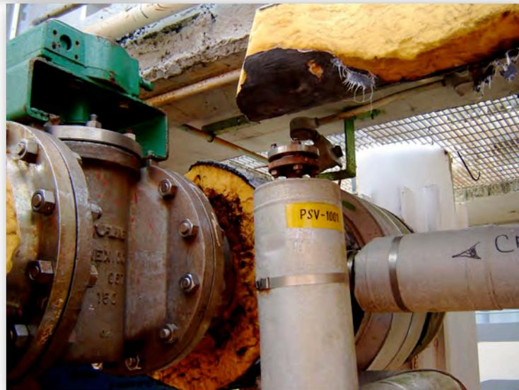
**Figura 13:** Ejemplo de tuberías con tornillería desgastada y en buen estado vistas en campo.
