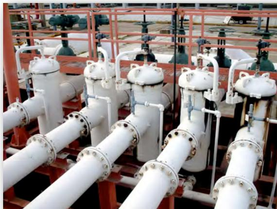
*Figura 8: Visualización de las conexiones en campo de las tuberías de proceso (bridas, codos, tuercas unión, coples, etc.).*
