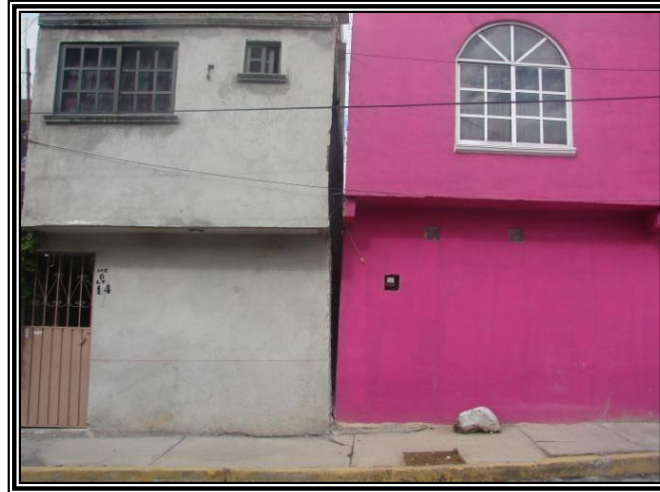
Figura 3.25. Imagen que muestra la separación entre casas, en la calle Carlota, en la colonia El Edén.
