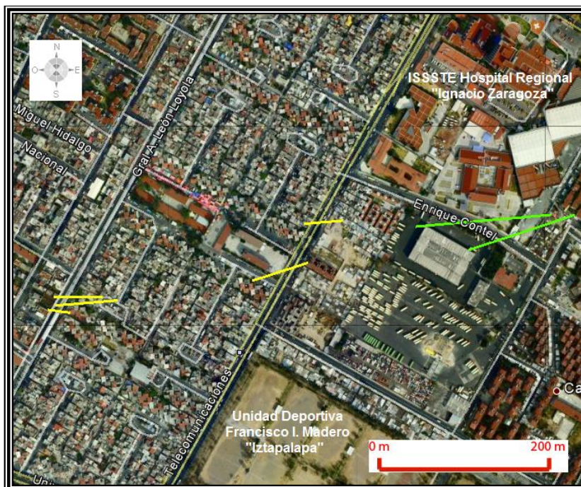
Figura 4.11. Imagen que muestra las fracturas y las fallas, en color amarillo y verde respectivamente, representadas en una imagen de Google Earth, en la Colonia Guelatao de Juárez.
