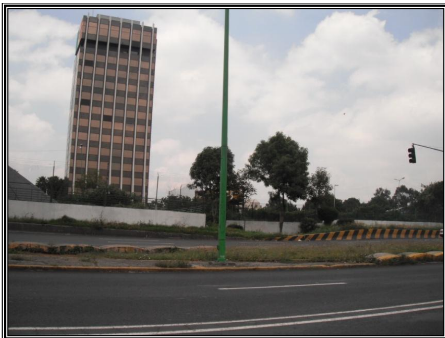
Figura 3.59. Fotografía que muestra la forma irregular del terreno en el Eje Central Lázaro Cárdenas, en la colonia Valle del Tepeyac.
