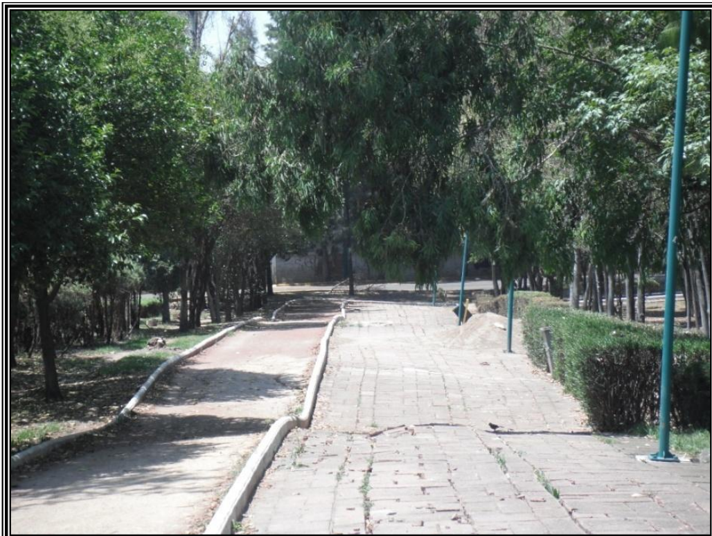
Figura 3.90. Fotografía que muestra la forma irregular del terreno en la Alameda Norte, Pueblo Santa Bárbara.
