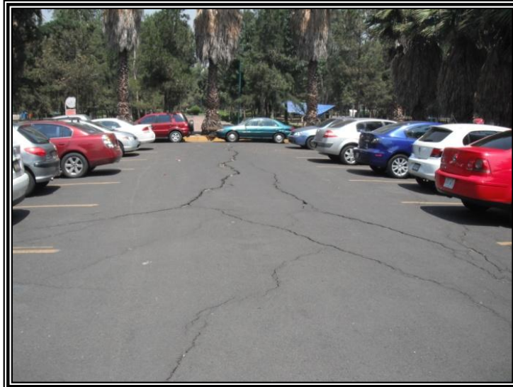
Figura 1.4.11. Fotografía que muestra un panorama general de un sitio con pavimento fracturado en Azcapotzalco D.F.
