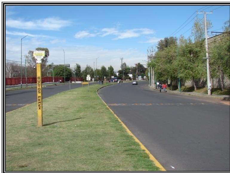
Figura 6.26. Ductos de gas de PEMEX en las inmediaciones de la Unidad Profesional Adolfo López Mateos, Campus Zacatenco del IPN; las fracturas cruzan de forma oblicua los ductos.
