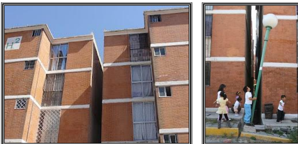
Figura 3.13. Imagen que muestra la separación entre los edificios de la Unidad Concordia Zaragoza.
