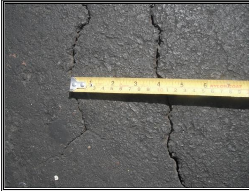
Figura 1.4.9. Distancia entre fracturas en el pavimento de Av. México, Xochimilco D.F.
