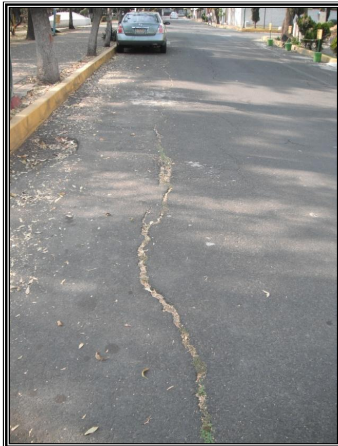
Figura 3.76. Fractura en el pavimento de Avenida de las Dalias, colonia Jardines de Coyoacán.
