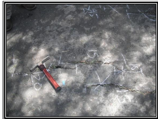
Figura 1.4.3. a) Marcado con gis de las fracturas; b) Acercamiento para ver detalles de las fracturas marcadas en Xochimilco.
