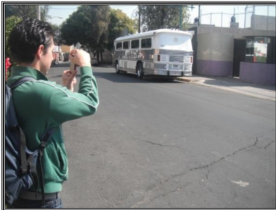
Figura 1.4.10. Toma de fotografía del pavimento con fracturas en Av. México, Xochimilco D.F.
