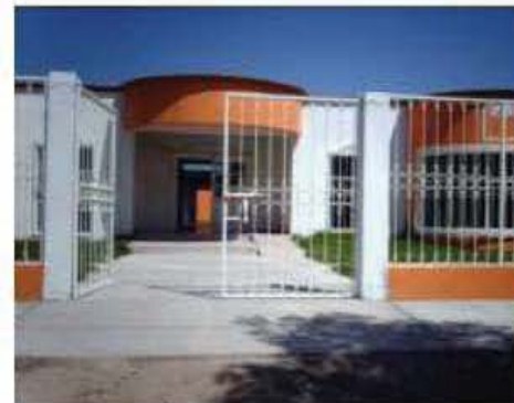
22 Imagen 10. Acceso principal a las oficinas.
