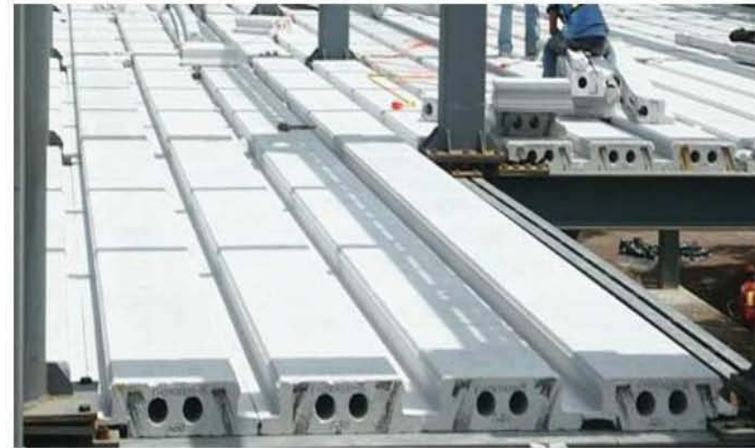
Imagen 39 entrepiso de 15 cm de espesor de poliestireno.
