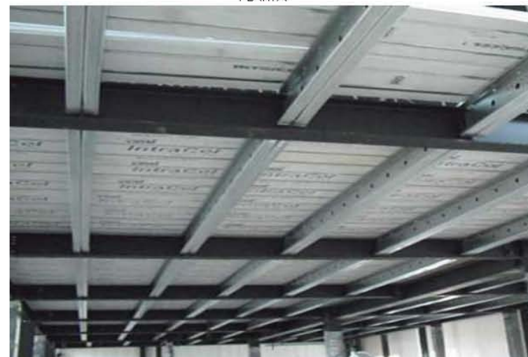
Imagen 38 del sistema constructivo vigas IR y largueros sigma
