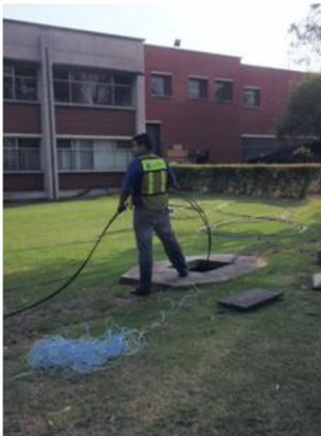
Figura 1.11 Inmersión de fibra Óptica
