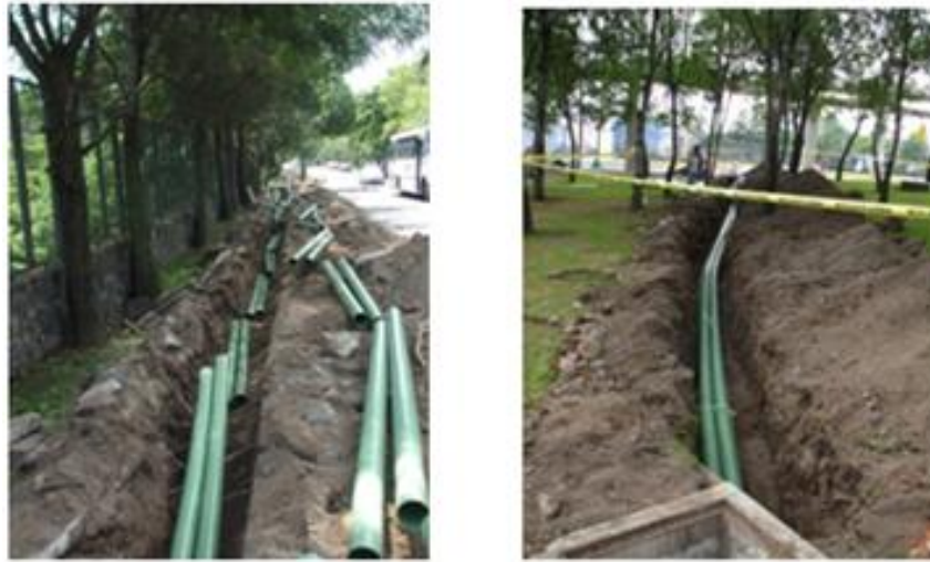
Figura 1.6 Colocación de Tubería
