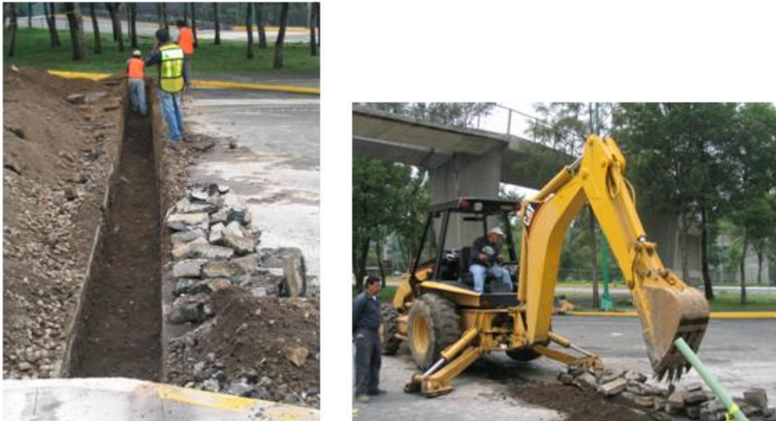
Figura 1.5 Construcción de la canalización
