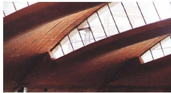
IMAGEN 1 Y 2: Cubierta enladrillada (Eladio Dieste)
