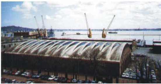
IMAGEN 1 Y 2: Cubierta enladrillada (Eladio Dieste)
