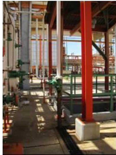
Figura 64. Descarga de agua de lavado al drenaje pluvial
