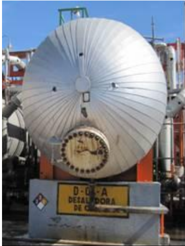
Figura 4. Desaladoras D-01-A/B.
