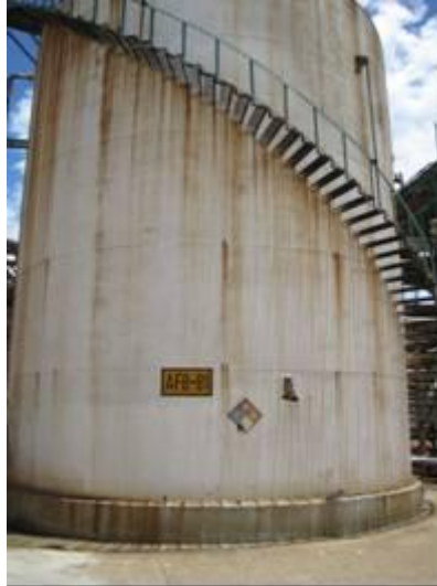
Figura 36. Tanque de almacenamiento de agua para desalado.
