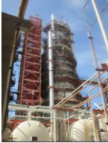
Figura 55. Convertidor catalítico F3-R-1
