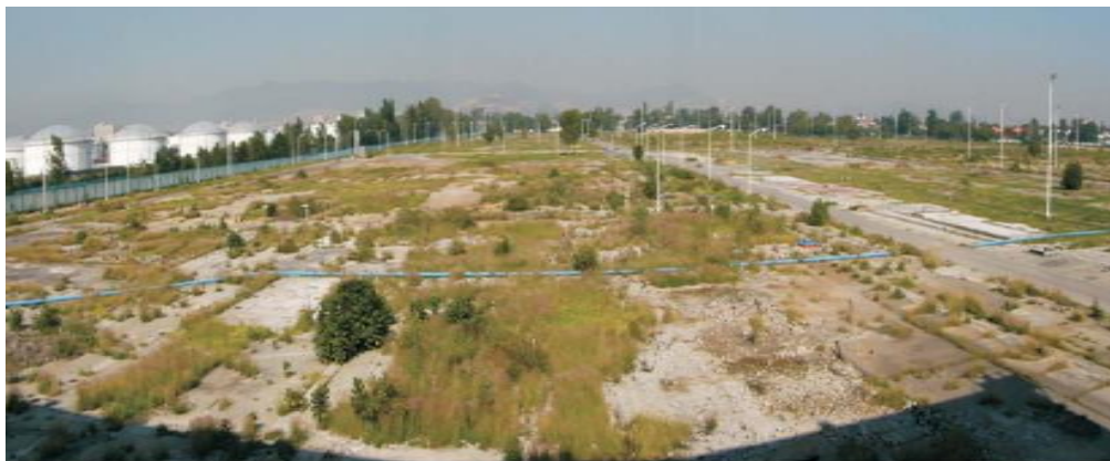
Figura 4.24 Vista de la Refinería 18 de Marzo después del desmantelamiento.
