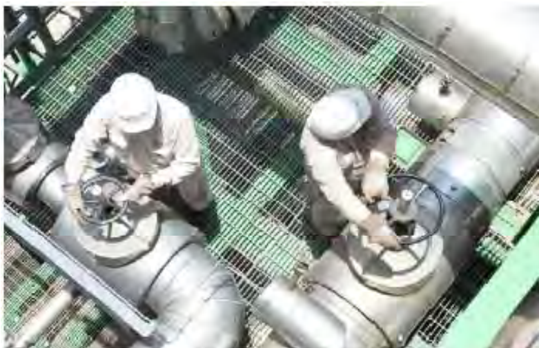
Figura 1. Mantenimiento a las instalaciones de proceso.
