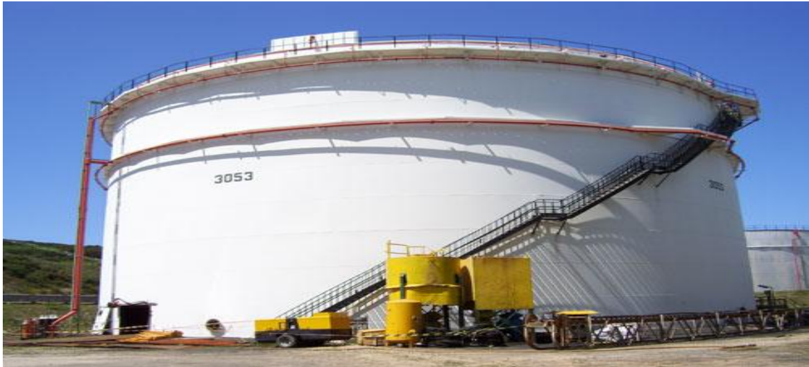
Figura 8. Tanque de almacenamiento de Techo Fijo.
