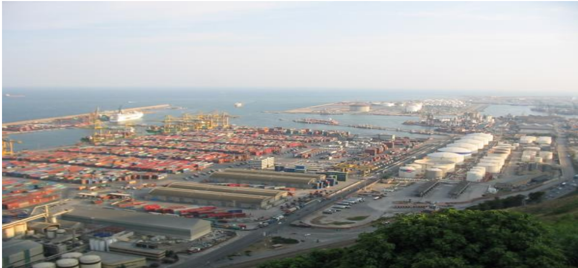
Figura 5. Instalaciones de Almacenamiento
