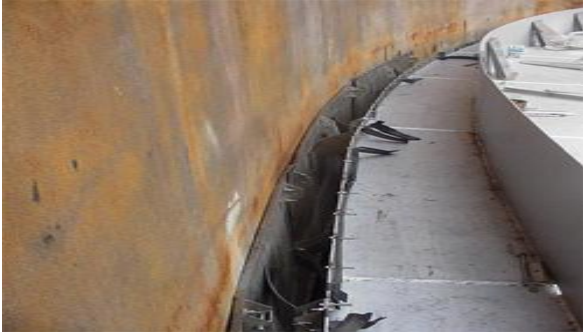
Figura 10. Sello tipo metálico
