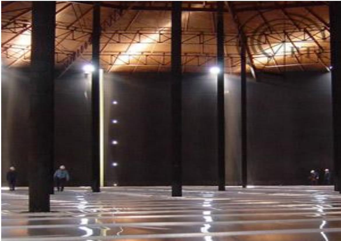
Figura 15. Tanque de almacenamiento soportado por columnas internas
