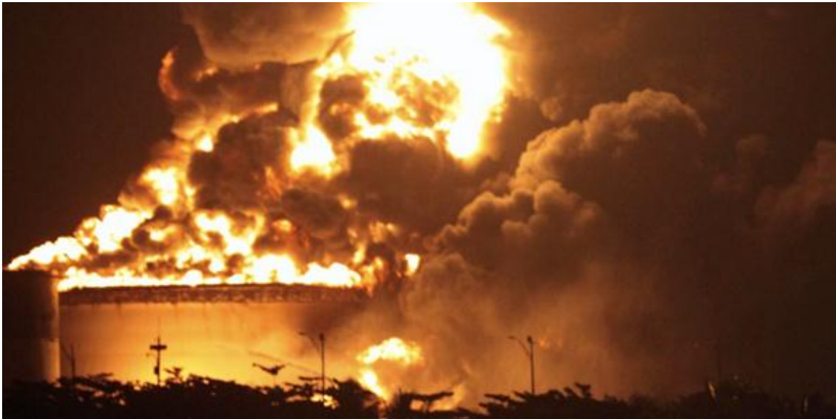
Figura 46. Incendio en Tanque Atmosférico de Almacenamiento
