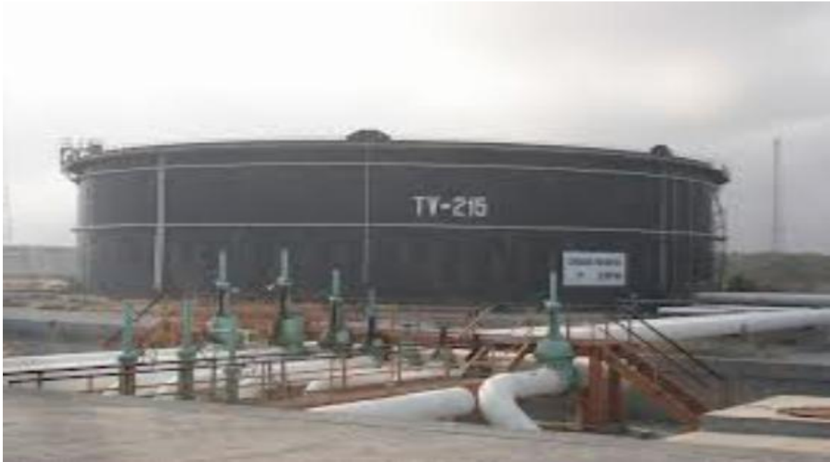
Figura 67. Tanque de almacenamiento que requiere reflejar la radiación solar (blanco)
