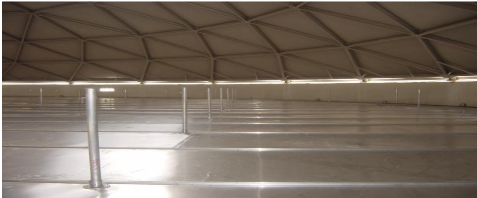
Figura 14. Interior de tanque de techo flotante con domo
