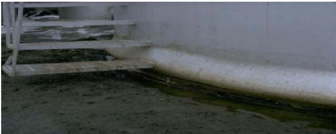
Figura 32. Pandeo “Pata de Elefante”.
