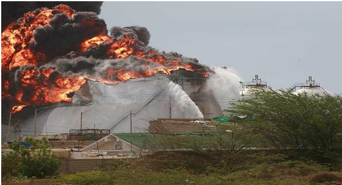
Figura 43. Incendio en tanque de almacenamiento con desprendimiento de techo.
