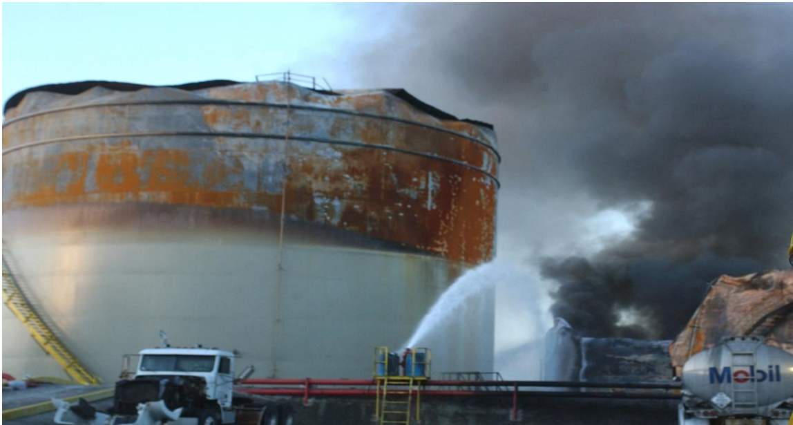
Figura 42. Incendio por Hundimiento de Techo.
