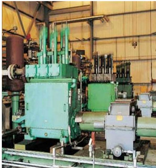
***Figura 2.5. Bomba reciprocante del tipo vertical instalada en campo***
