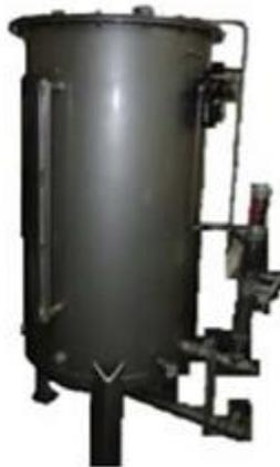
***Figura 4.34. Tanque de aceite de reposición***
