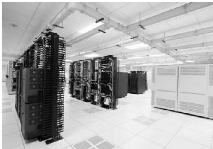
Figura 2.3. Distribución uniforme de gabinetes del SITE con espacio libre flexible.
