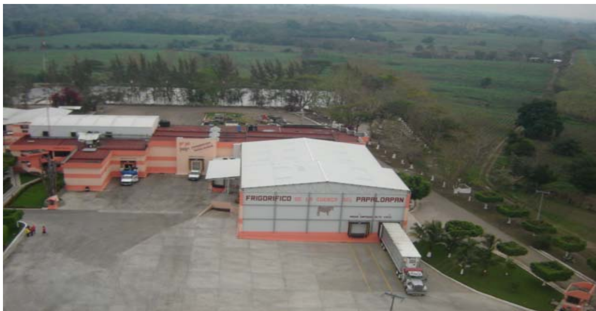
Foto 21. Instalaciones de rastro frigorífico TIF 101
