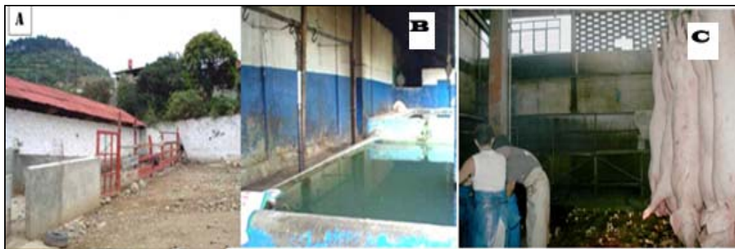
Foto 26. Instalaciones deficientes de rastros en el país. A) Inexistencia de piso y techo en los corrales de estabulación. B) Utilización de agua no potable (Fotos COFEPRIS) C) Pésima higiene de instalaciones y mal manejo de vísceras (Foto Juana Villada).
