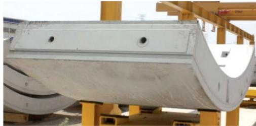
Figura 1.18 Junta plana típica de una dovela (Peña *et al*, 2012)
