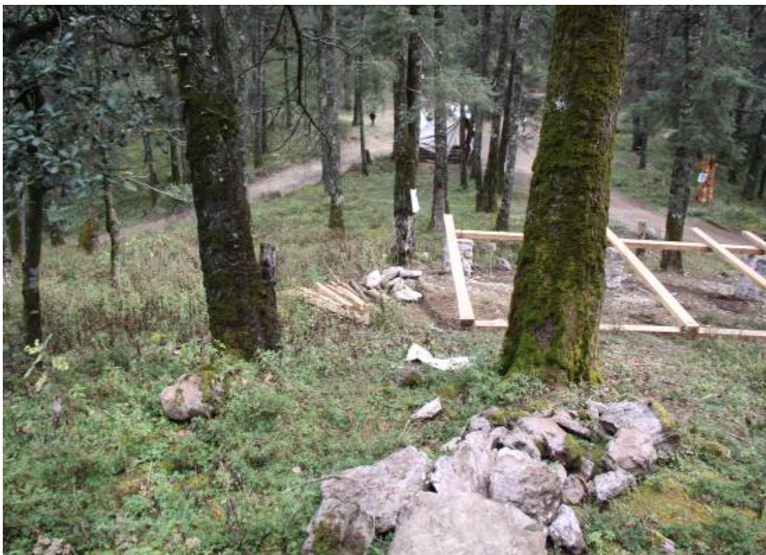
Muestra de una construcción injustificada.
