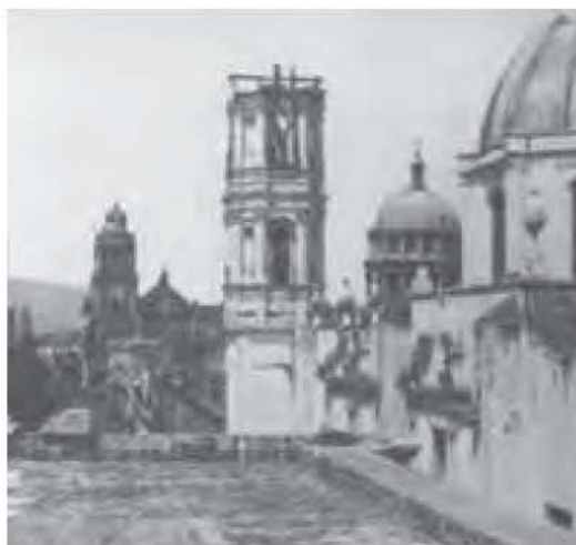
Vista de la torre del convento antes de ser demolida
