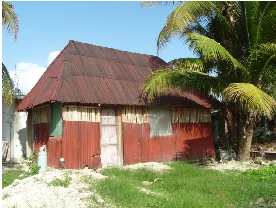
Figura 3.16. Vivienda tipo en la Reserva
