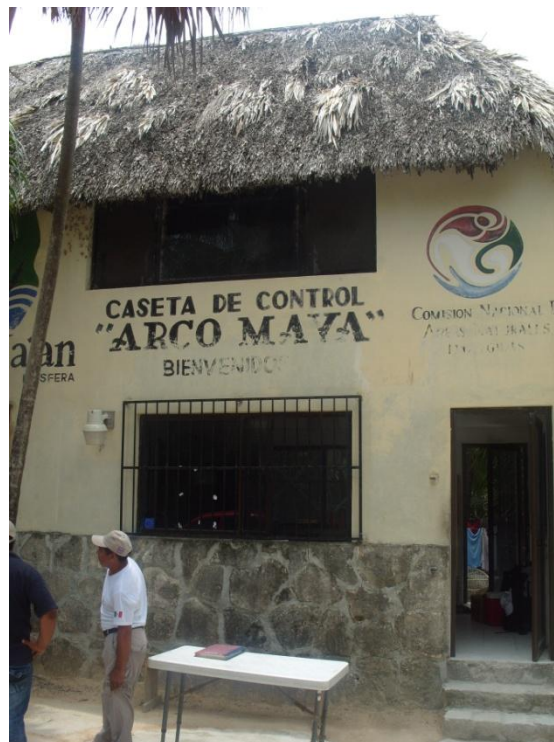
Figura 3.10. Infraestructura de vigilancia. Caseta de control entrada norte
