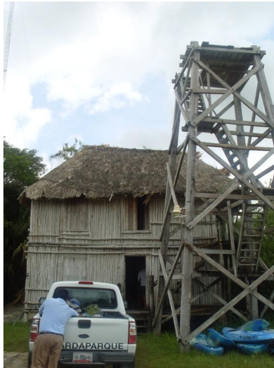
Figura 3.11. Infraestructura de vigilancia: camioneta de guardaparque y torre de vigilancia
