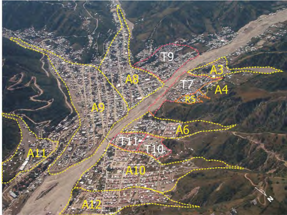
Figura 31. Vista aérea de la ciudad de Motozintla, Chiapas. Se observa el complejo urbano y ubicación de las casas habitación sobre abanicos aluviales antiguos. Nótese el crecimiento poblacional sobre las estructuras fluviales y el avance descontrolado de la mancha urbana hacia zonas altas de las laderas y sobre las planicies aluviales.
