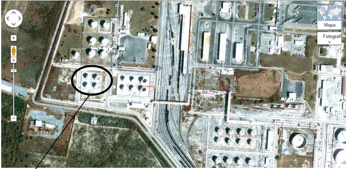
Figura 3.1 Vista de los 4 tanques a los que se les implementó el sistema.
