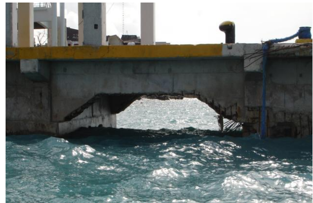
Fotografía No 27.- Fisuras en las trabes principales.
