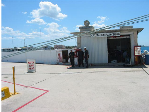
Fotografía No 49.- Cuarto de bombas se observa que se obstruía los sistemas de amarre y las vistas panorámicas.
