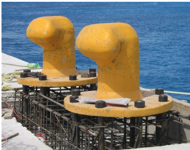
Fotografía No 47.- Bitas de patente. polimérico.
