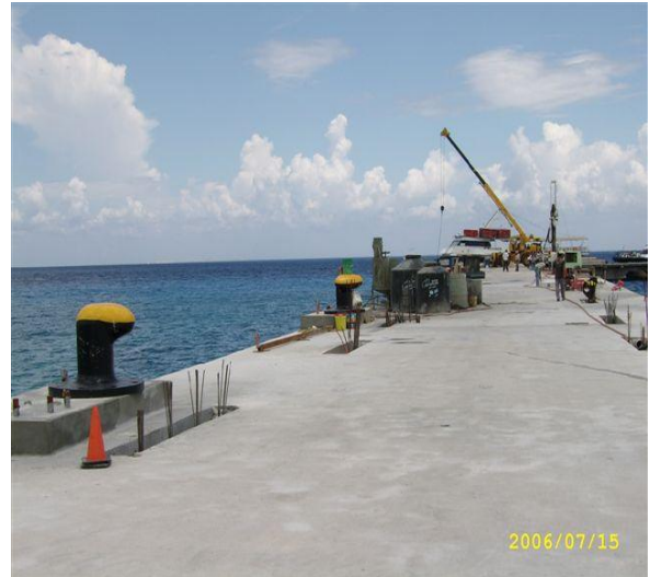
Fotografía No 46.- Colocación de bitas en losas L4
