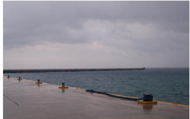
Fotografía No 21.- Bitas de amarre, en la pasarela de acceso.
