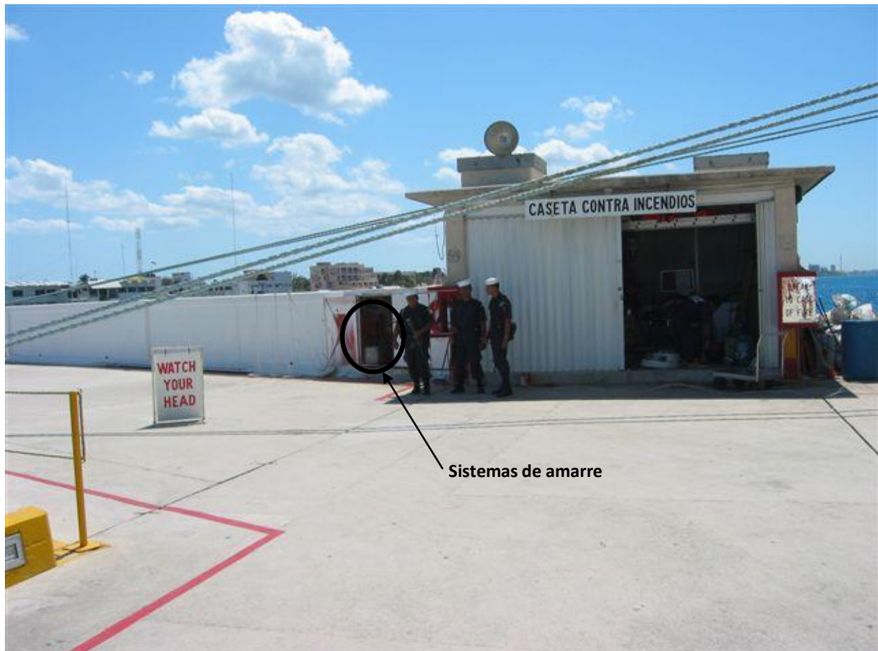
Fotografía No 17.- Cuarto de bombas se observa que se obstruía los sistemas de amarre y las vistas panorámicas. Dentro del círculo se muestra los elementos de amarre.
