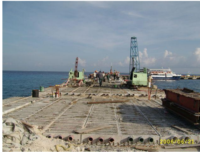
Fotografía No 42.- Colocación de losas con ductos.
