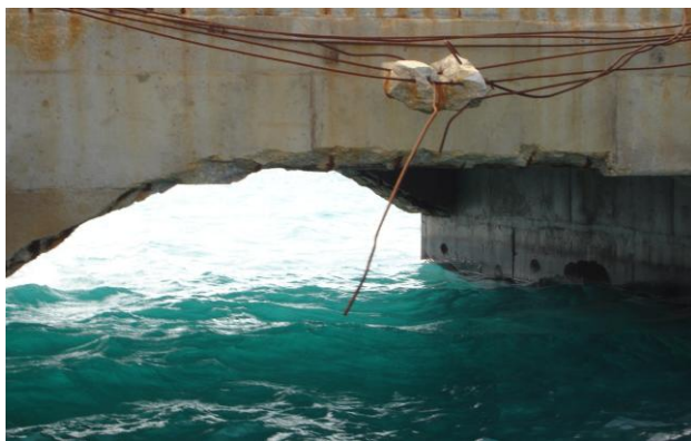
Fotografía No 26.- Trabes principales dañadas.
