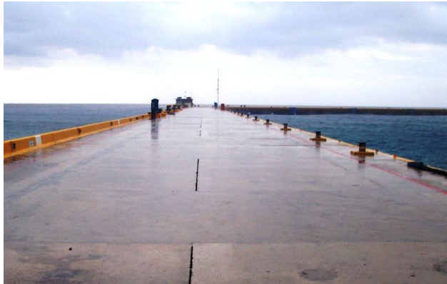
Fotografía No 20.- Pasarela de acceso del muelle, estructura original.
