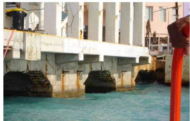
Fotografía No 27.- Fisuras en las trabes principales.
