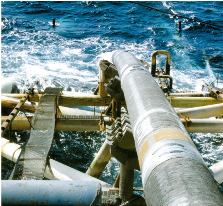
Figura 3.11 Tendido del gasoducto, Langeled (conocida como Britpipe) tubería de gran diámetro que transporta gas natural desde Nyhamna en la costa oeste de Noruega a Inglaterra a través de la plataforma de Sleipner.
