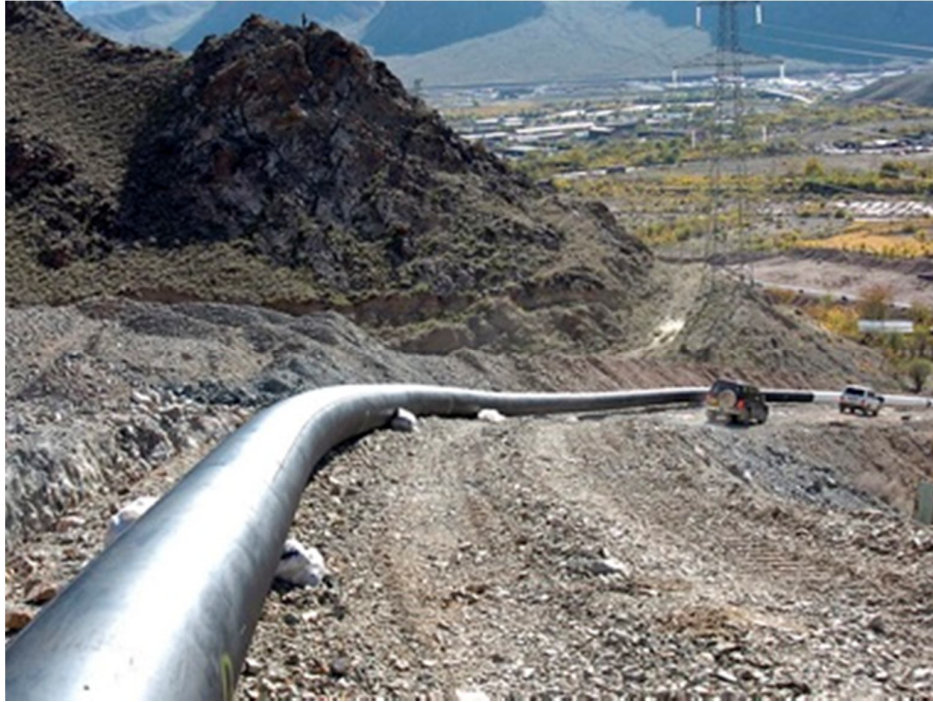
Figura.3.2 Gasoducto tendido en suelo delgado de granito
