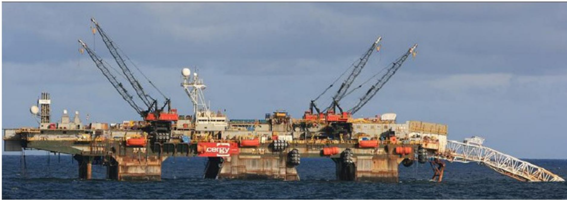
Figura 3.16 Plataforma tendedora de tubería en lecho marino para aguas profundas
