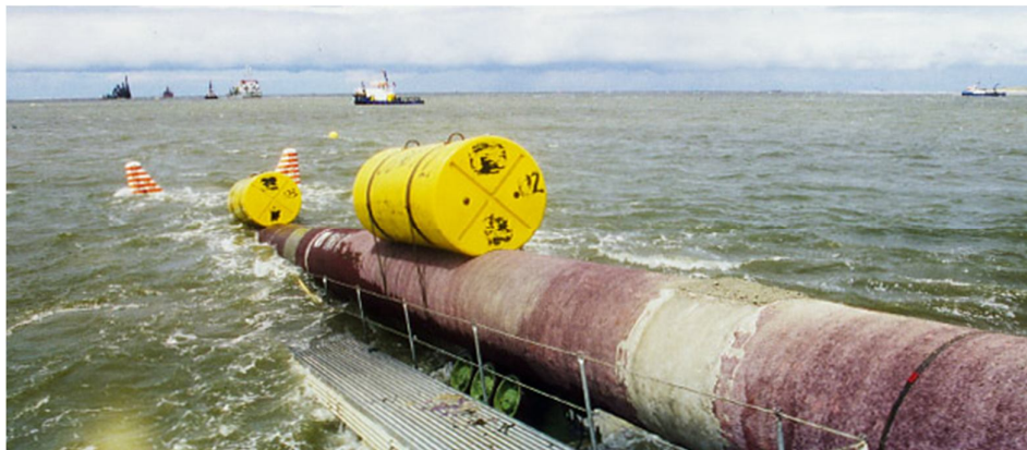
Figura 3.15 Gasoducto construido por Statoil en 2 años para Bohlen & Doyen GmbH con una inversión de 75 millones de dólares.
