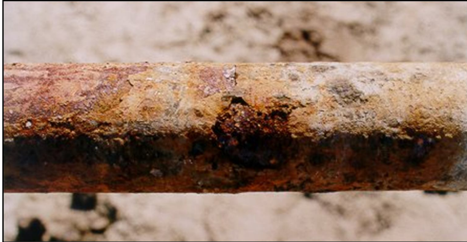
Figura. 3.24 Corrosión por H_2S y CO_2 en Tubería 3 1/2" grado N-80
