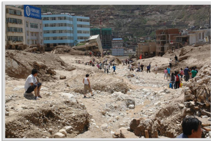
Figura 2.10. Deslizamientos de tierra en Zhouqu, China. Agosto 8 de 2010. Foto AP / Xinhua, Gong Zhiyong. Fuente: http://comunidad.geosyr.com.ar/blogs/noticias/archive/2010/08/30/los-deslizamientos-de-tierra-en-zhouqu-county-china.aspx .
