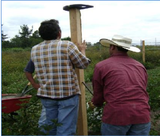
Foto31: Nivelando el poste con un nivel de mano
