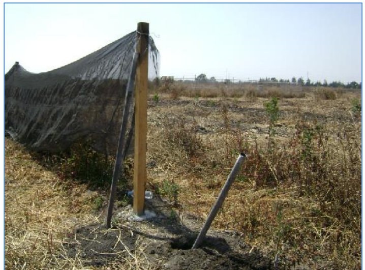
Foto 34: Contrafuerte colocado
