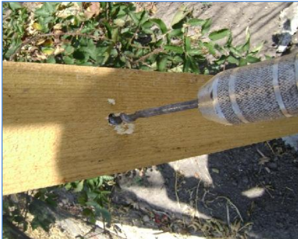
Foto 37: Perforando el poste, para que pase el alambre.
