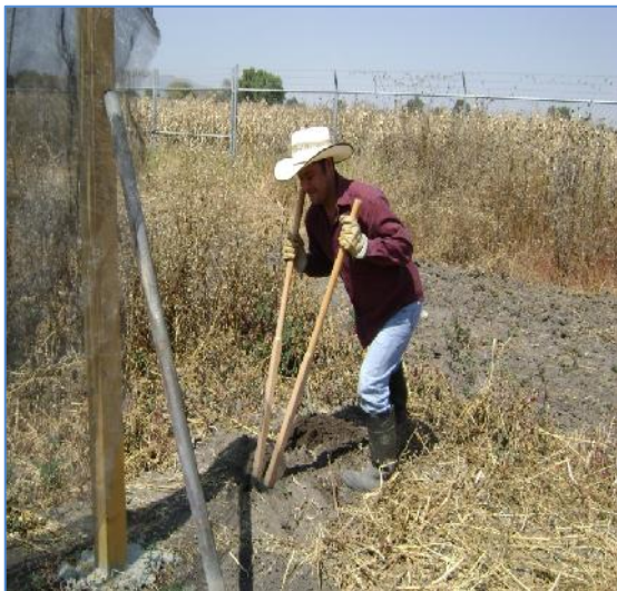
Foto 33: Haciendo el hoyo para el contrafuerte
