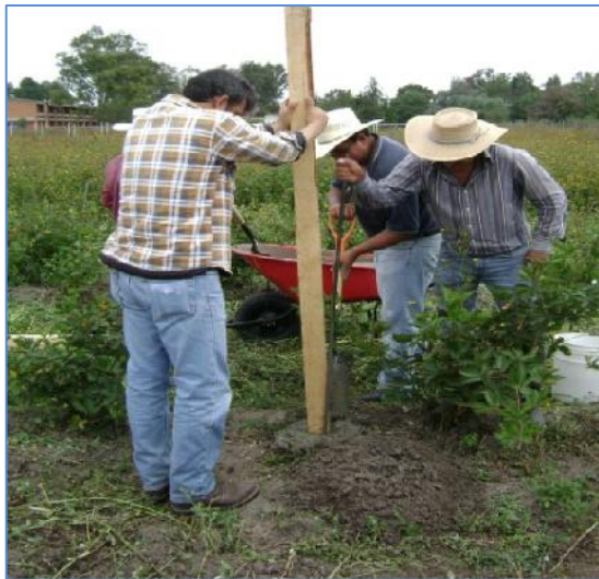
Foto 29: Rellenando el poste con concreto
