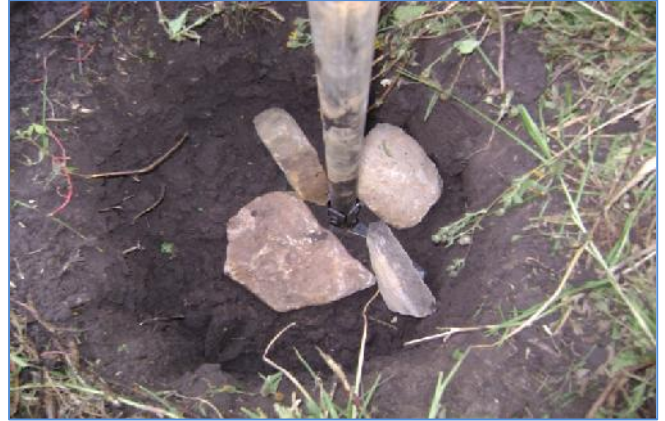
Foto 9: Para los postes que van en las esquinas se le colocaron 4 piedras y apisonado
