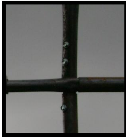
Foto 1 tornillo pija colocado en la estructura.
