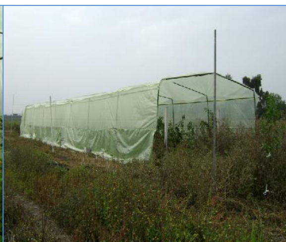
Foto 24: Macrotúnel terminado vista por fuera
