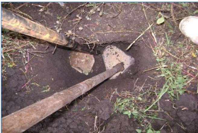
Foto 6 : Colocar las piedras y apisonar
