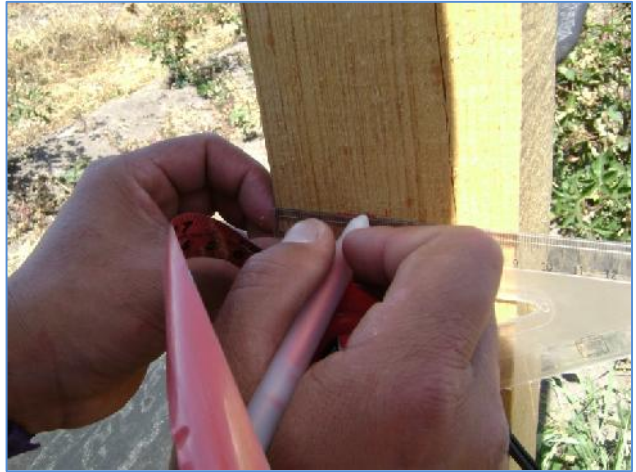
Foto 36: Sacando los niveles para colocar el alambre.
