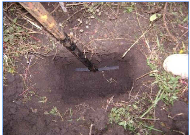
Foto 5: Colocación del tubo en su lugar definitivo.
