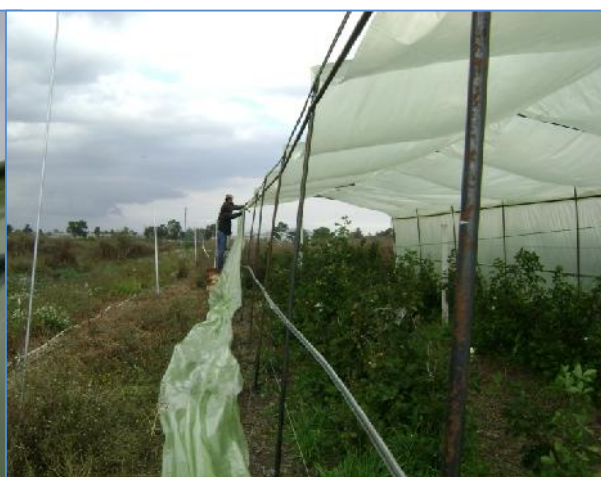
Foto 22: Colocando el plástico en la parte lateral.
