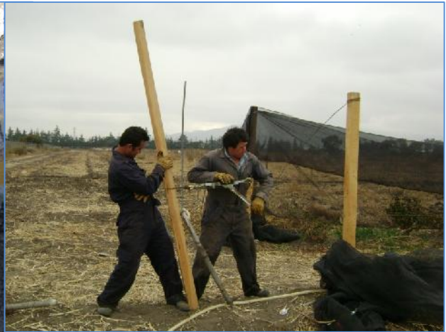
Foto 38: Tensando el alambre.
