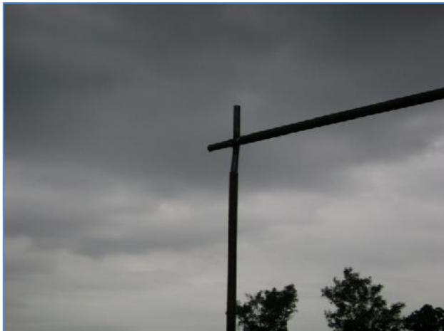
Foto 16: Ensamble de la estructura.
