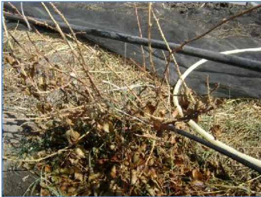
Foto 42: Sistema de riego terminado y funcionando.
