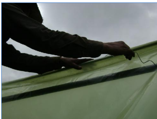
Foto 21: Colocando el plástico y engrapándolo al cortinero con alambre zig-zag
