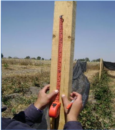
Foto 35: Sacando los niveles para colocar el alambre.
