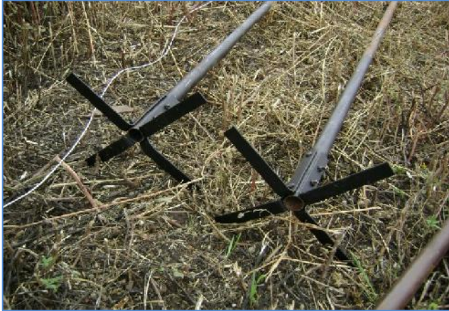
Foto 2: Colocación de las cruces en los tubos.
