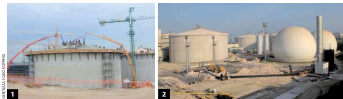
Figura 8. Construcción de biodigestor de cúpula fija (27).
