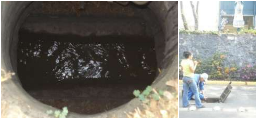
Figura 30. Pozo de visita sobre el Circuito Escolar a la Altura de la Facultad de Medicina (emisor 1)
